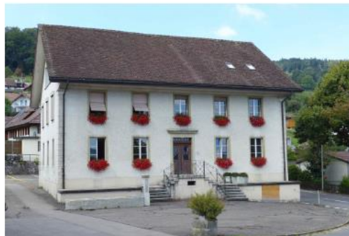
Ostseitige Schauffassade gegen den Dorfplatz (2016)
