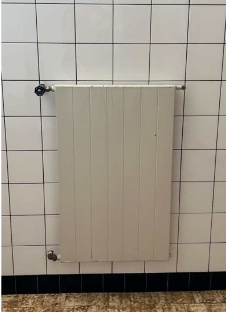
Heizwand in WC-Anlage (Ventile werden ersetzt)
