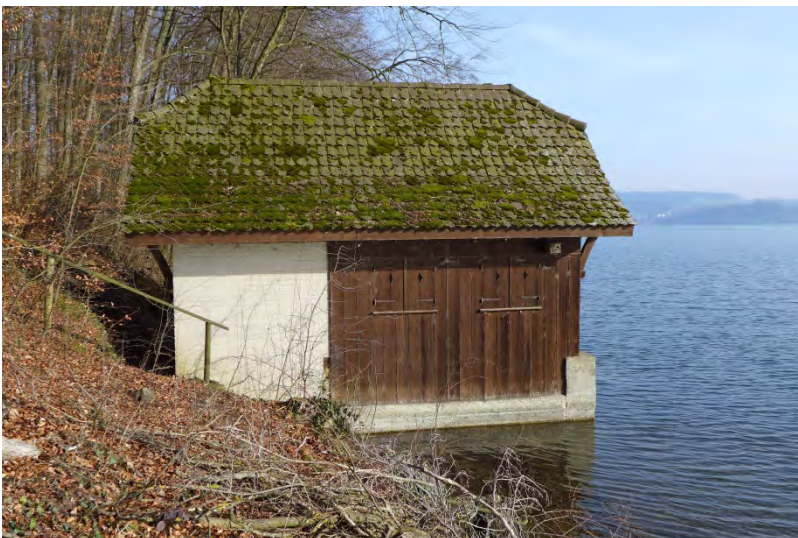
Bootshaus Vers.-Nr. 202, Ansicht von Süden (2017)
