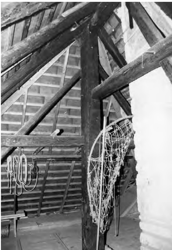
Einer-Hochstud (Bauernhausforschung 2000)
