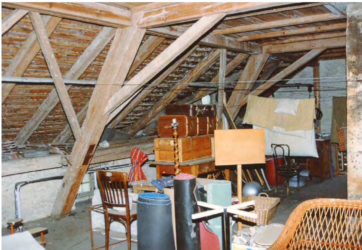
Dachkonstruktion mit liegendem Stuhl (Kurzinventar 1992)
