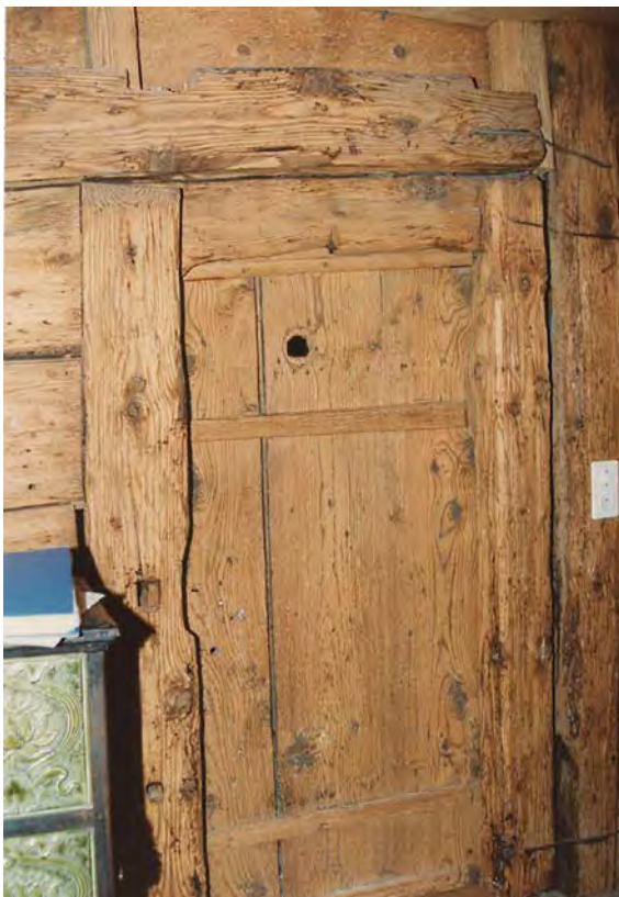
Obergadentür mit kielbogenartigem Sturz (Kurzinventar 1992)
