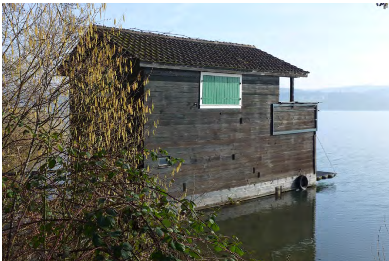
Bootshaus Vers.-Nr. 223, Ansicht von Süden (2017)
