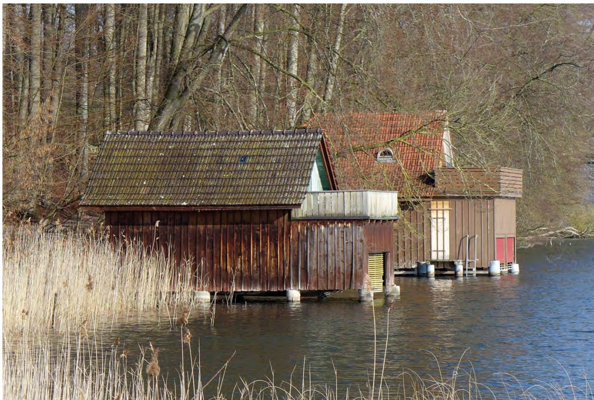
Ansicht des Bootshauses (hinten) von Süden (2017)
