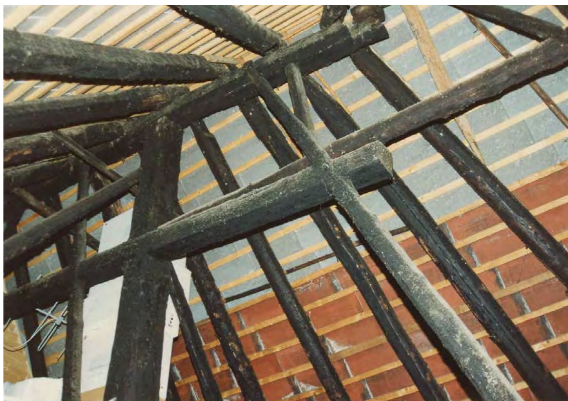
Ansatzpunkt Dachkonstruktion (Kurzinventar 1992)
