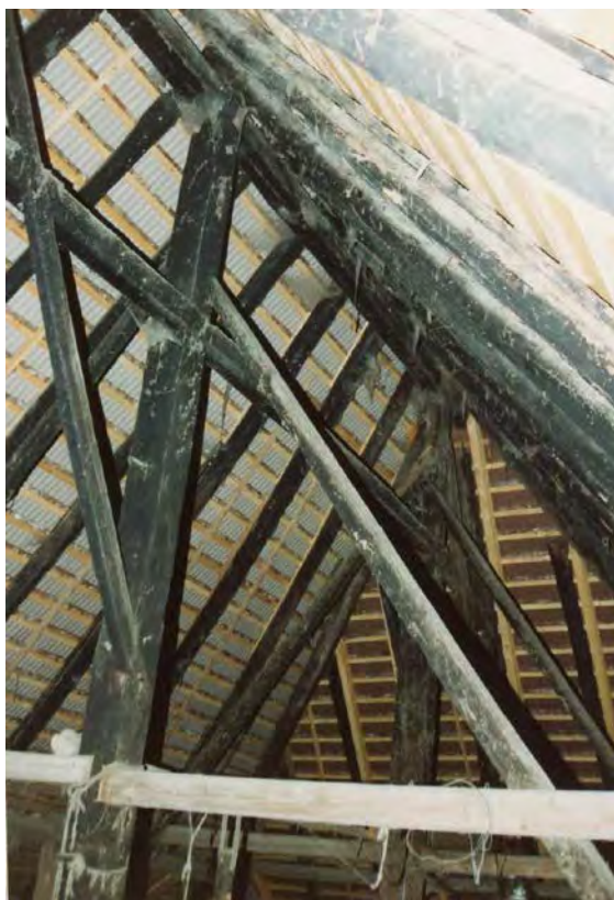
Rauchgeschwärzte Hochstud-Dachkonstruktion (Kurzinventar 1992)
