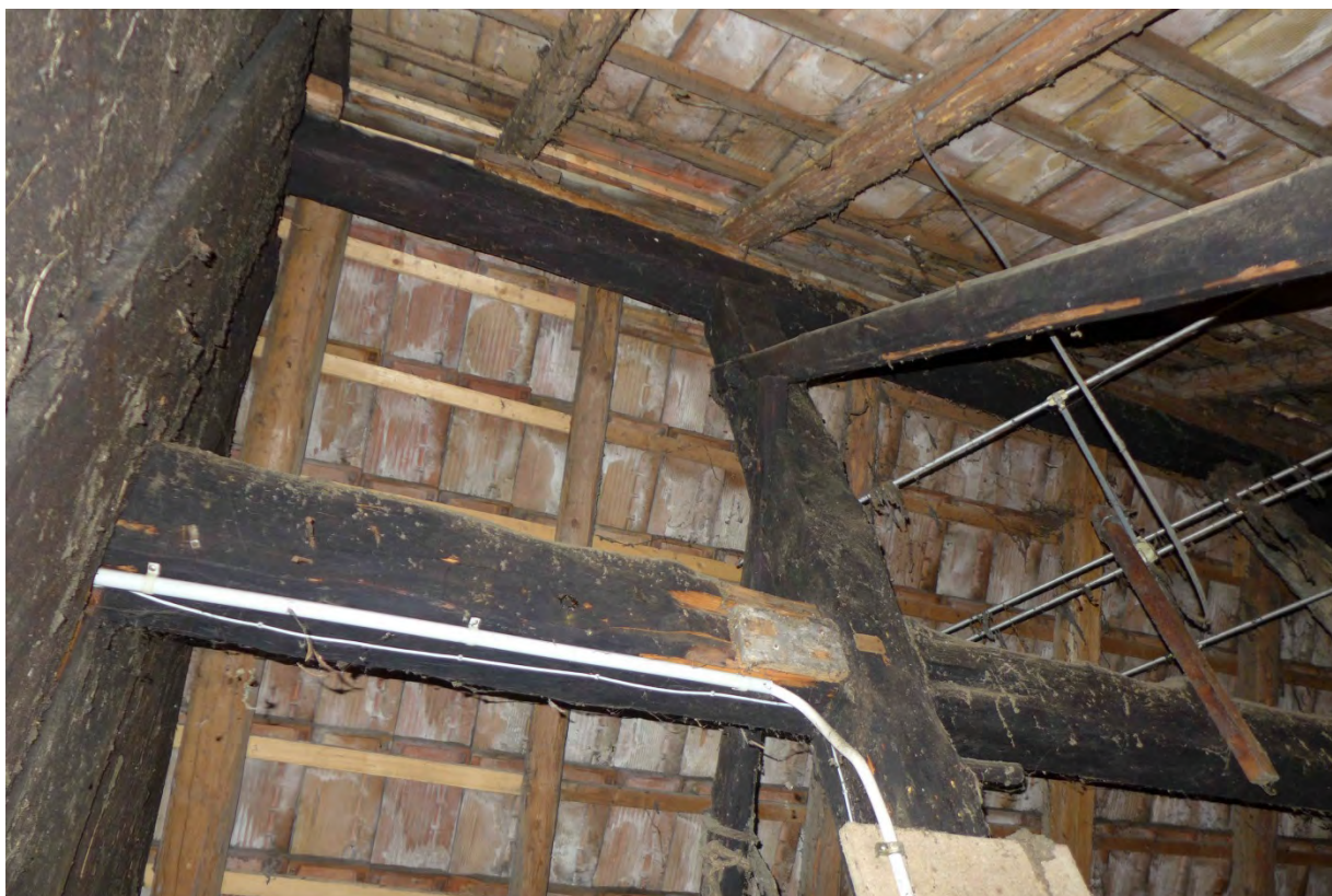
Detail Hochstud-Dachkonstruktion (2016)
