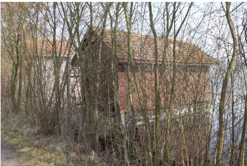
Bootshaus Vers.-Nr. 426, Ansicht von Süden (2017)
