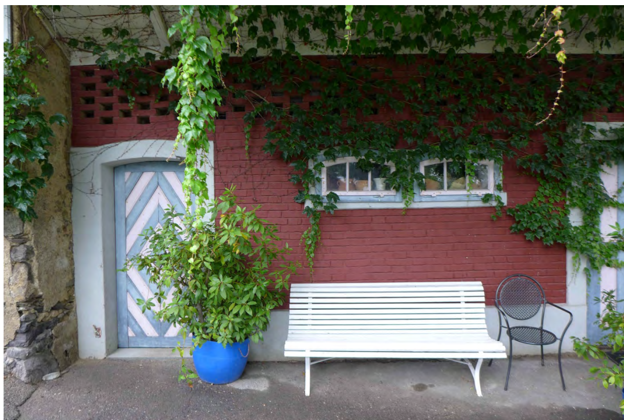
Stallfront aus Backsteinmauerwerk, frühes 20. Jh. (2016)
