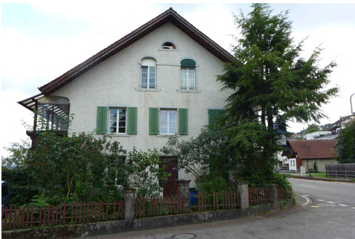
Nördliche Stirnfassade mit Haupteingang (2016)
