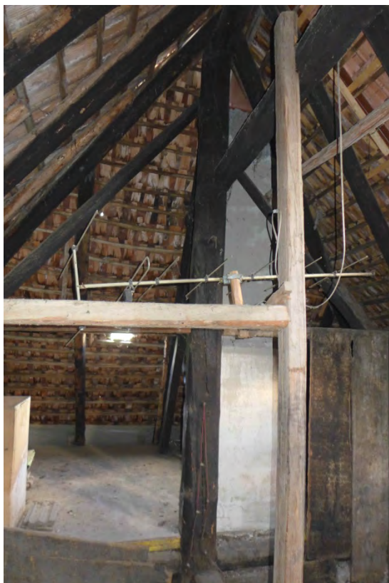
Rauchgeschwärzte Hochstud-Dachkonstruktion (2016)
