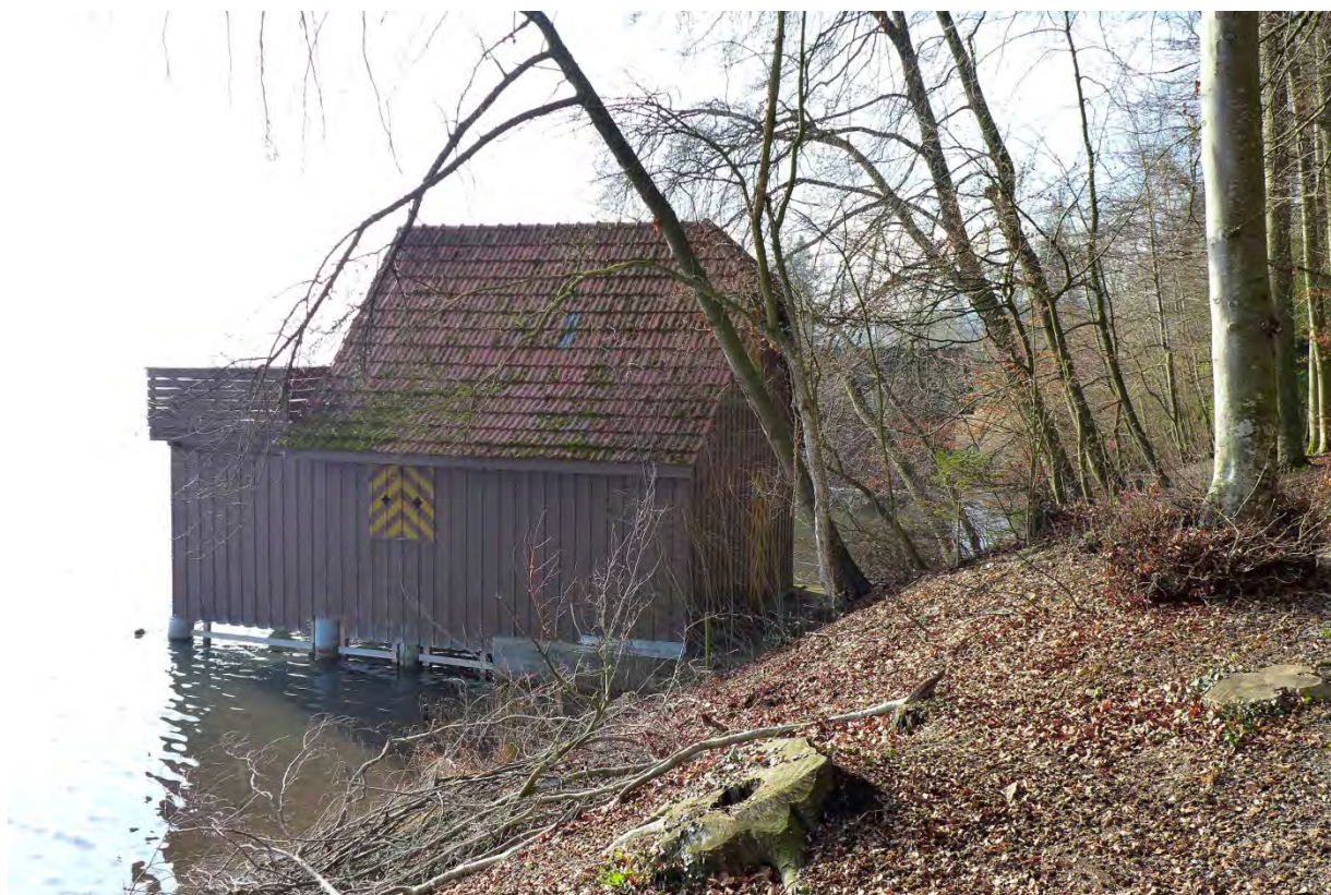
Uferseitige Ansicht von Norden (2017)
