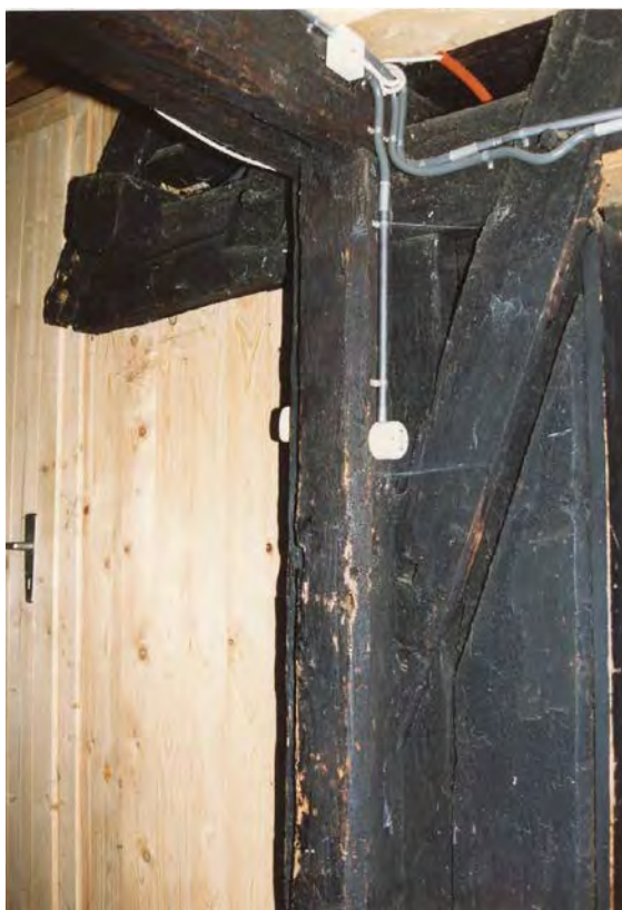
Detail Bohlenwand mit verblatteter Strebe (Kurzinventar 1992)
