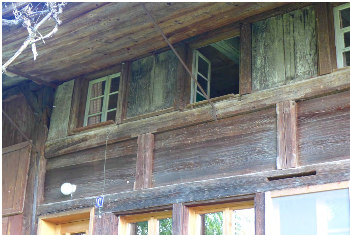
Detail Bohlenwand Obergeschoss (2016)
