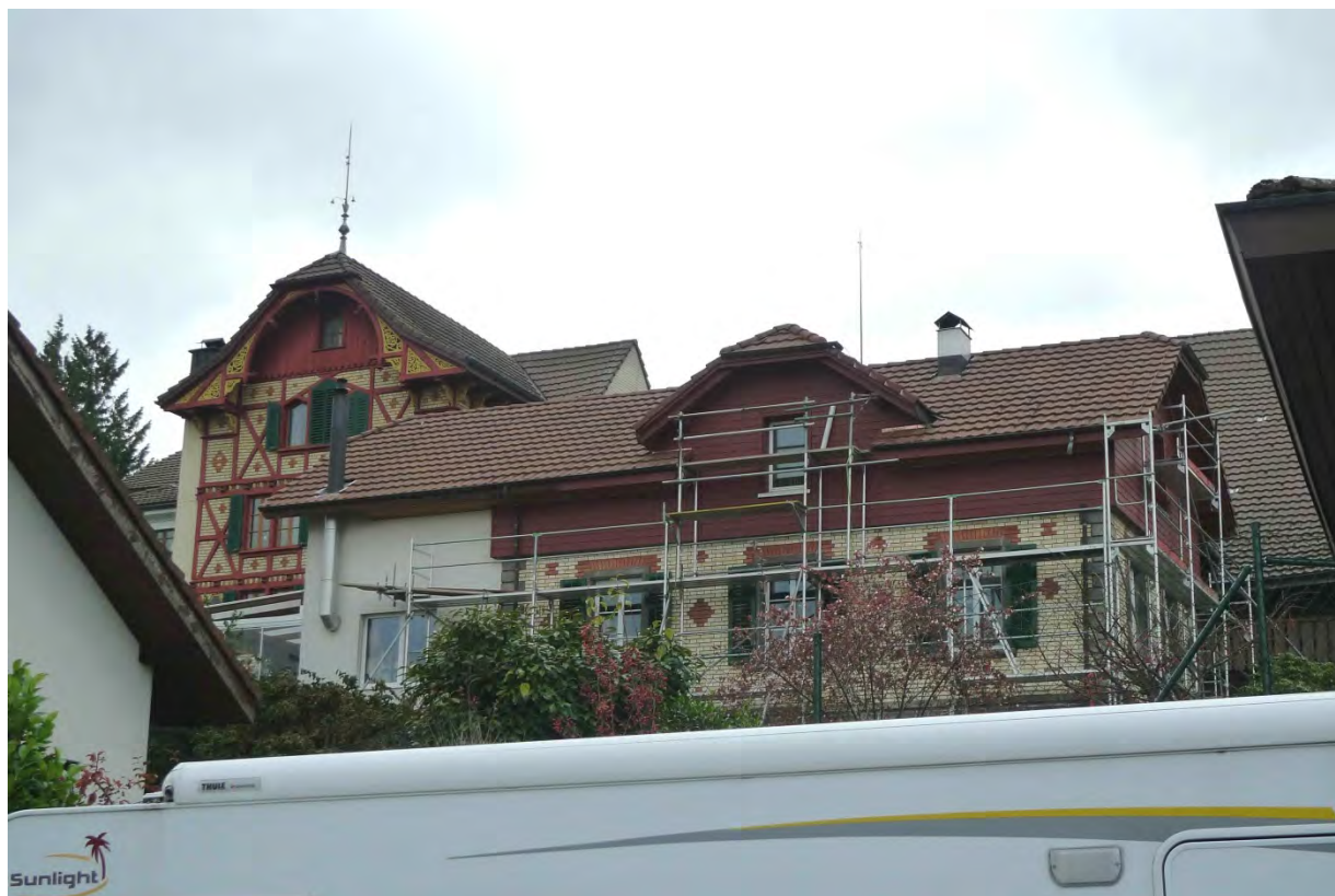
Östlicher Quergiebelanbau aus der Zeit um 1900 (2016)
