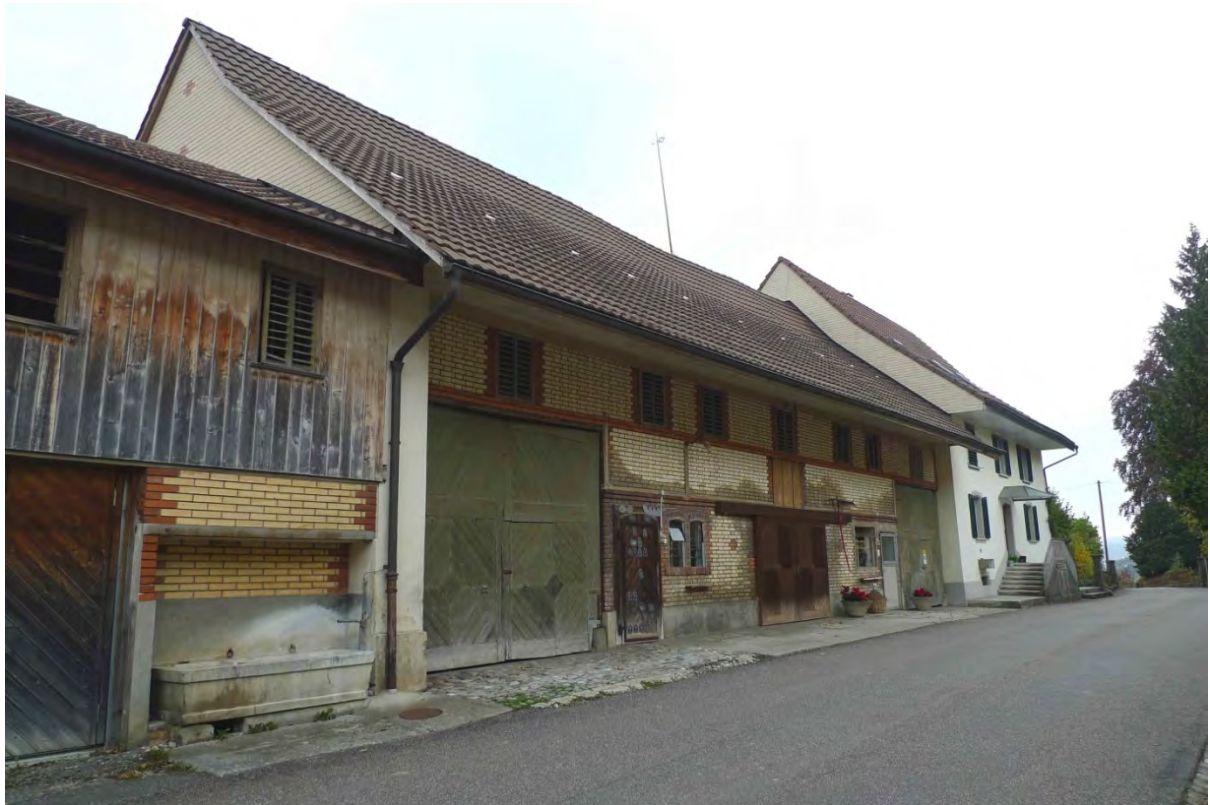
Westliche Fassadenfront mit massiv gemauertem Wohnteil und leicht niedrigerem Scheunentrakt mit Backsteinfassade (2016)
