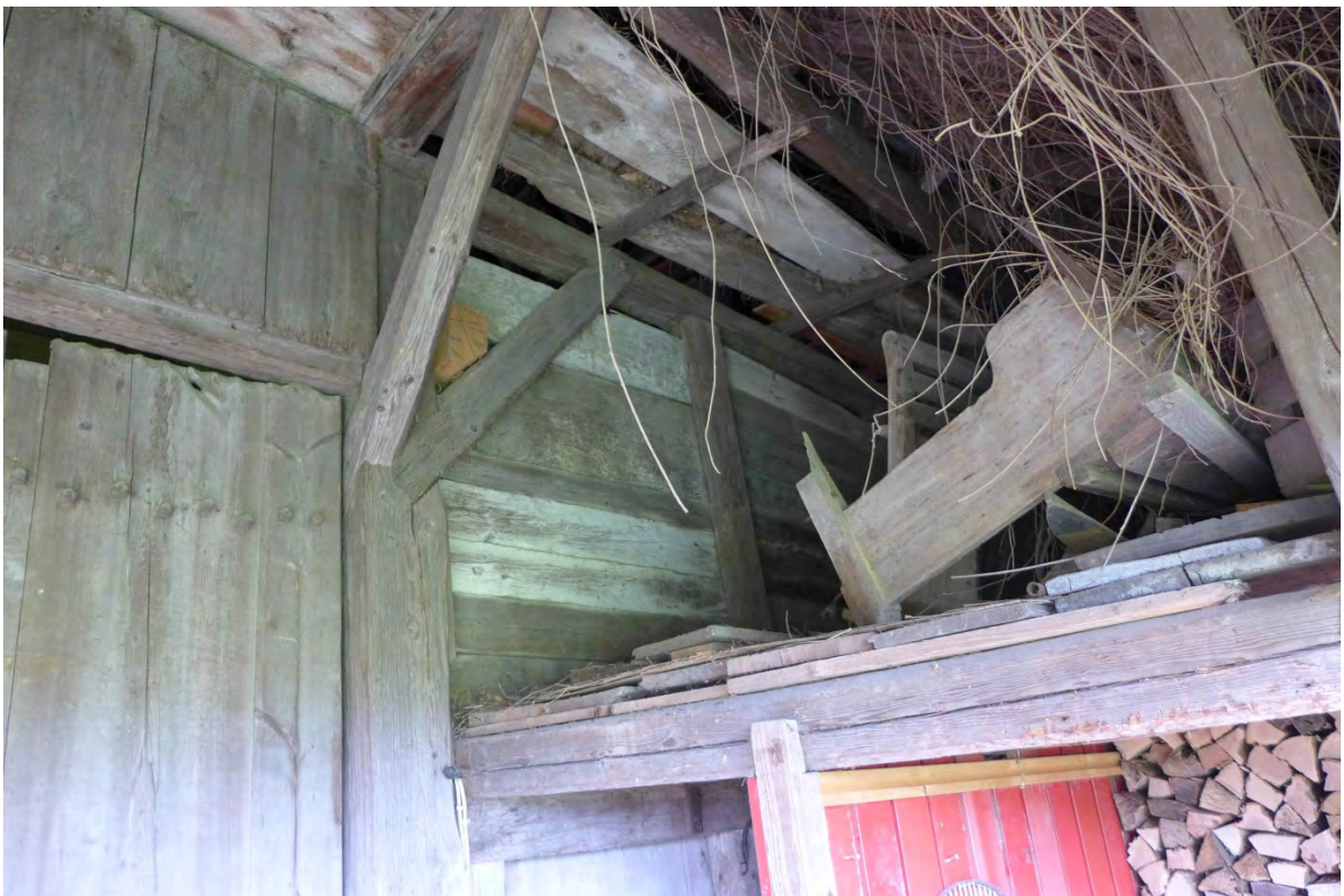
Alte Bohlenständerwand auf der Rückseite des Scheunenteils (2016)
