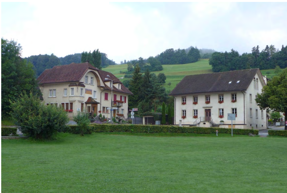
Situationsansicht von Nordosten (2016)
