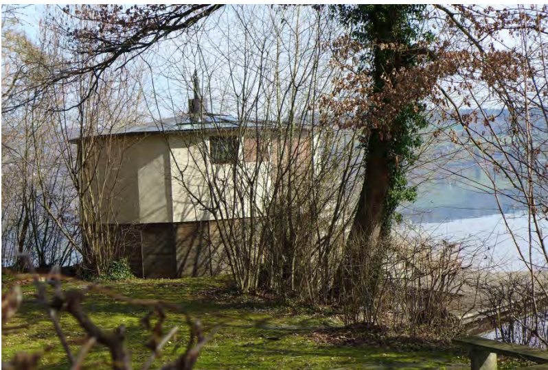
Wochenendhaus Vers.-Nr. 226, Ansicht vom Ufer (2017)
