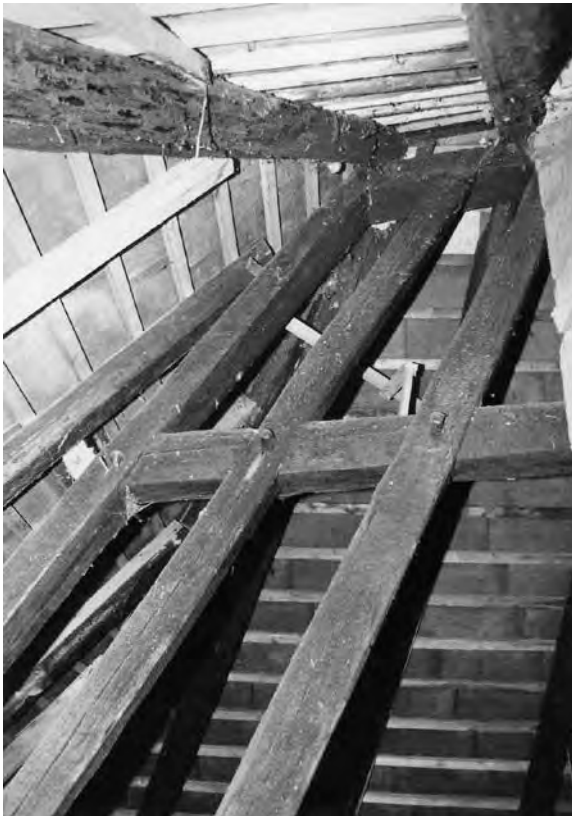
Dachkonstruktion von 1599, mit parallel geführten Windstreben (Bauernhausforschung 2000)
