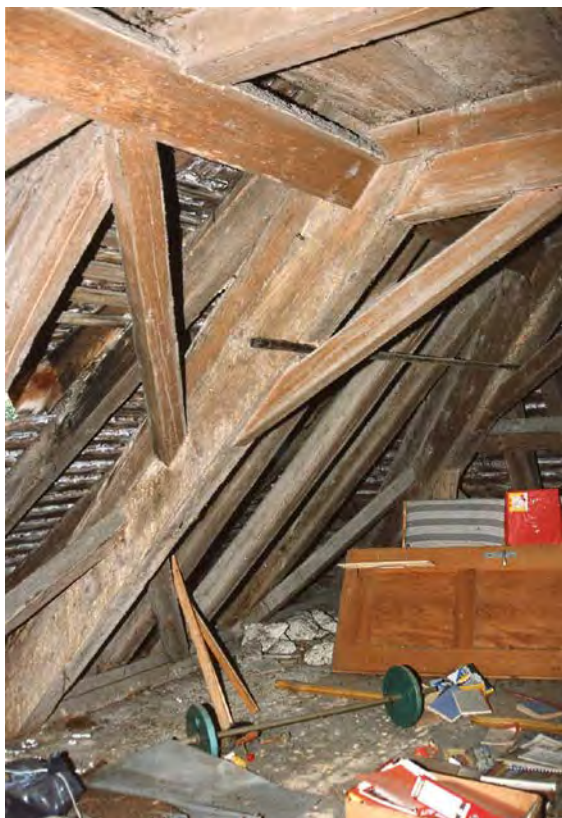
Dachkonstruktion mit liegendem Stuhl (Kurzinventar 1992)
