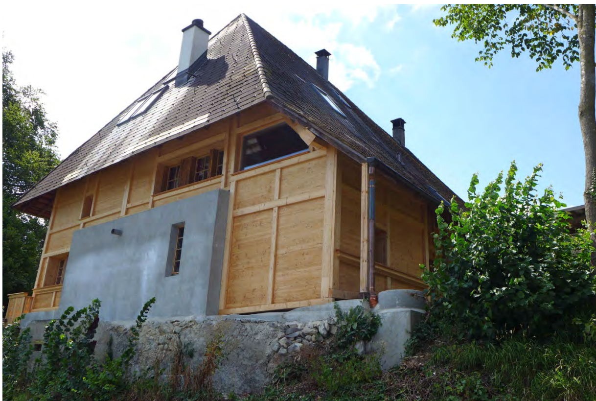
Östliche Stirnfassade, Zustand nach den baulichen Massnahmen von 2015 (Aufnahme 2016)
