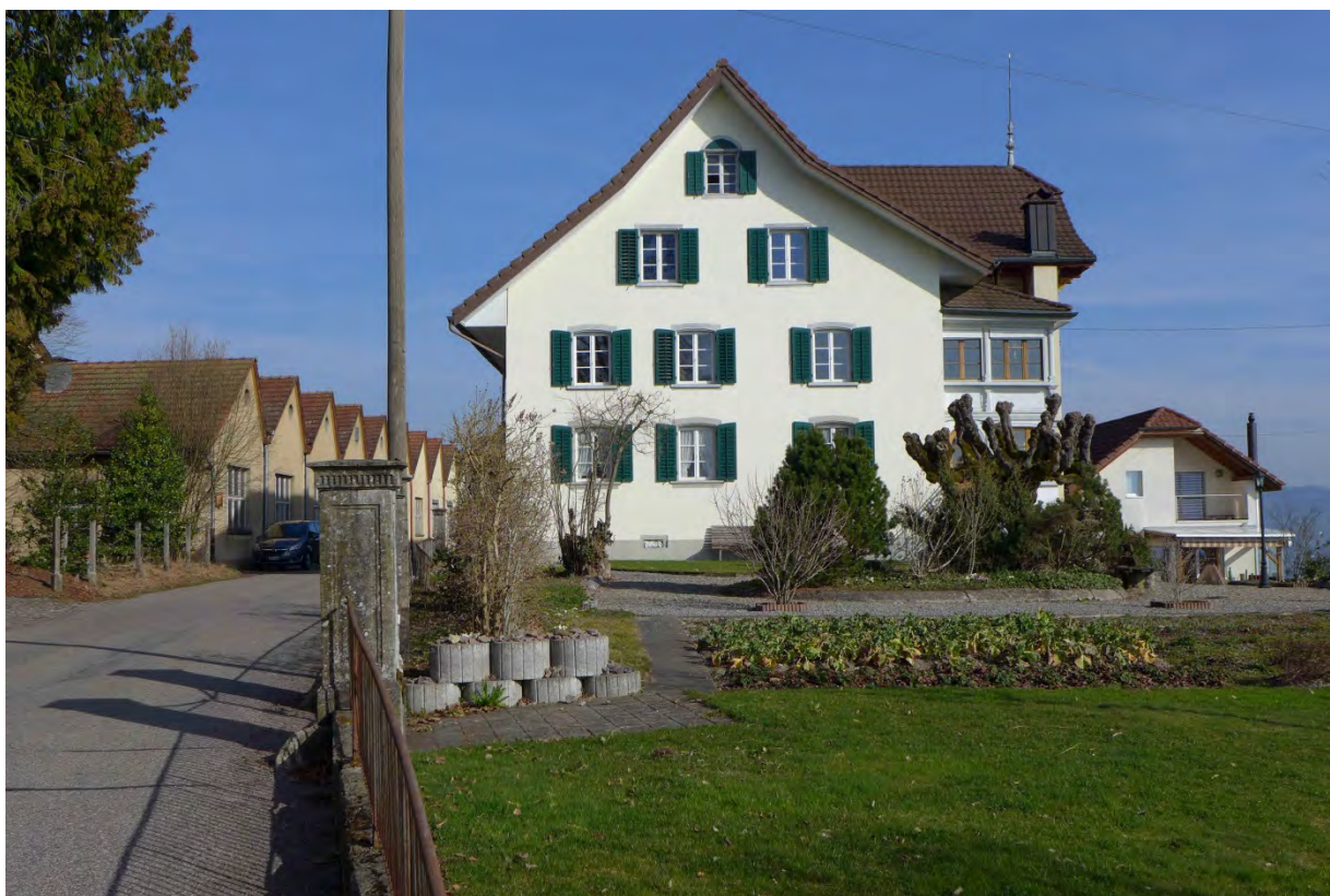
Situationsansicht mit Fabrikbauten im Hintergrund (2017)
