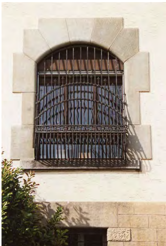
Vergitterte Fensteröffnung an der östlichen Eingangsfront (Kurzinventar 1992)
