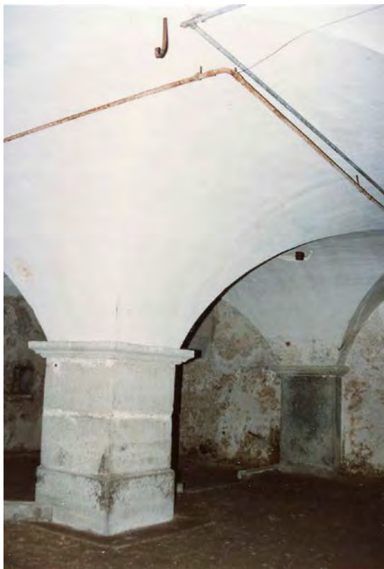
Keller mit Kreuzgratgewölbe und kräftigem Mittelpfeiler (Kurzinventar 1992)
