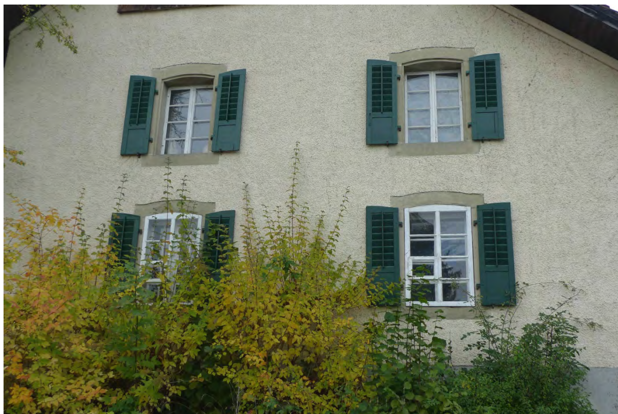
Östliche Stirnfassade mit stichbogigen Fensteröffnungen (2016)
