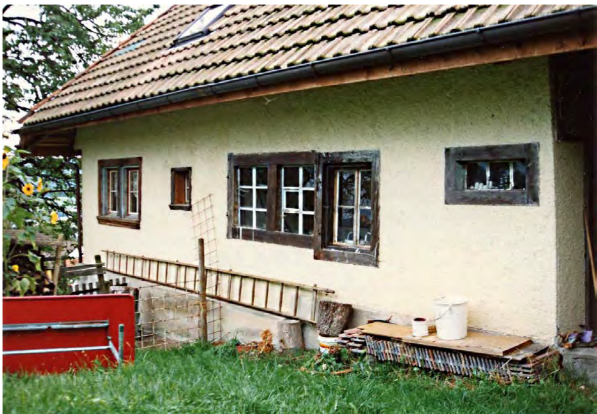
Hausrückseite, vor dem Umbau (Kurzinventar 1992)
