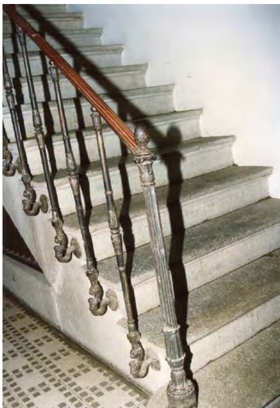
Interner Treppenaufgang mit filigranem Gusseisengeländer (Kurzinventar 1992)
