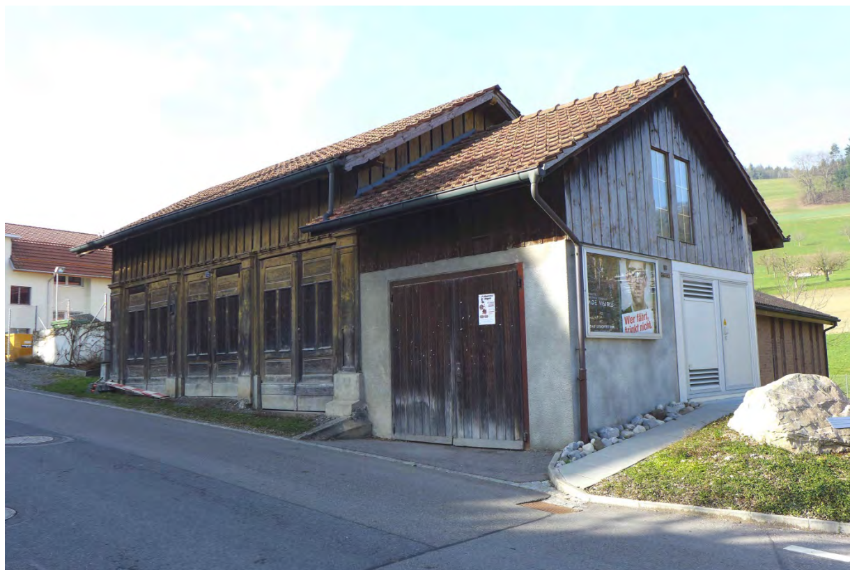
Jüngerer nördlicher Garagenanbau (2016)
