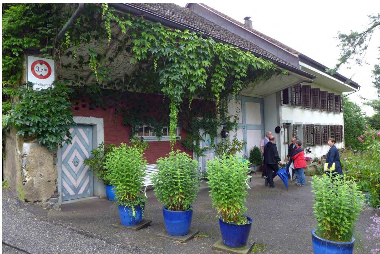
Südseitige Ansicht mit Wohnteil und Scheunentrakt mit geringfügig tieferer Firstlinie (2016)
