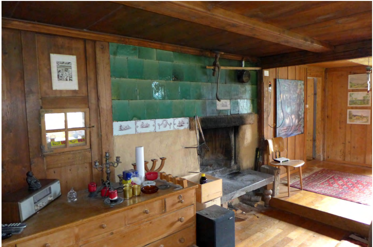
Stubenseitige Feuerwand und Durchreiche (2016)
