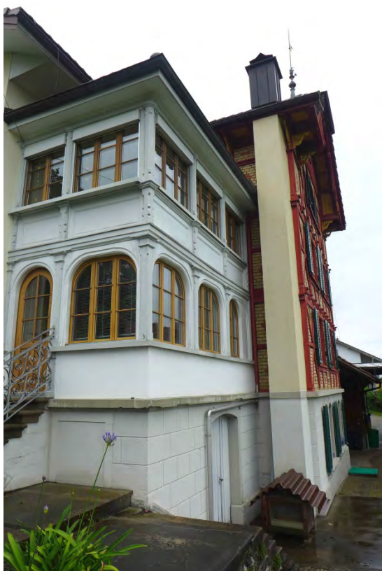
Ostseitiger Laubenanbau von 1894 (2016)
