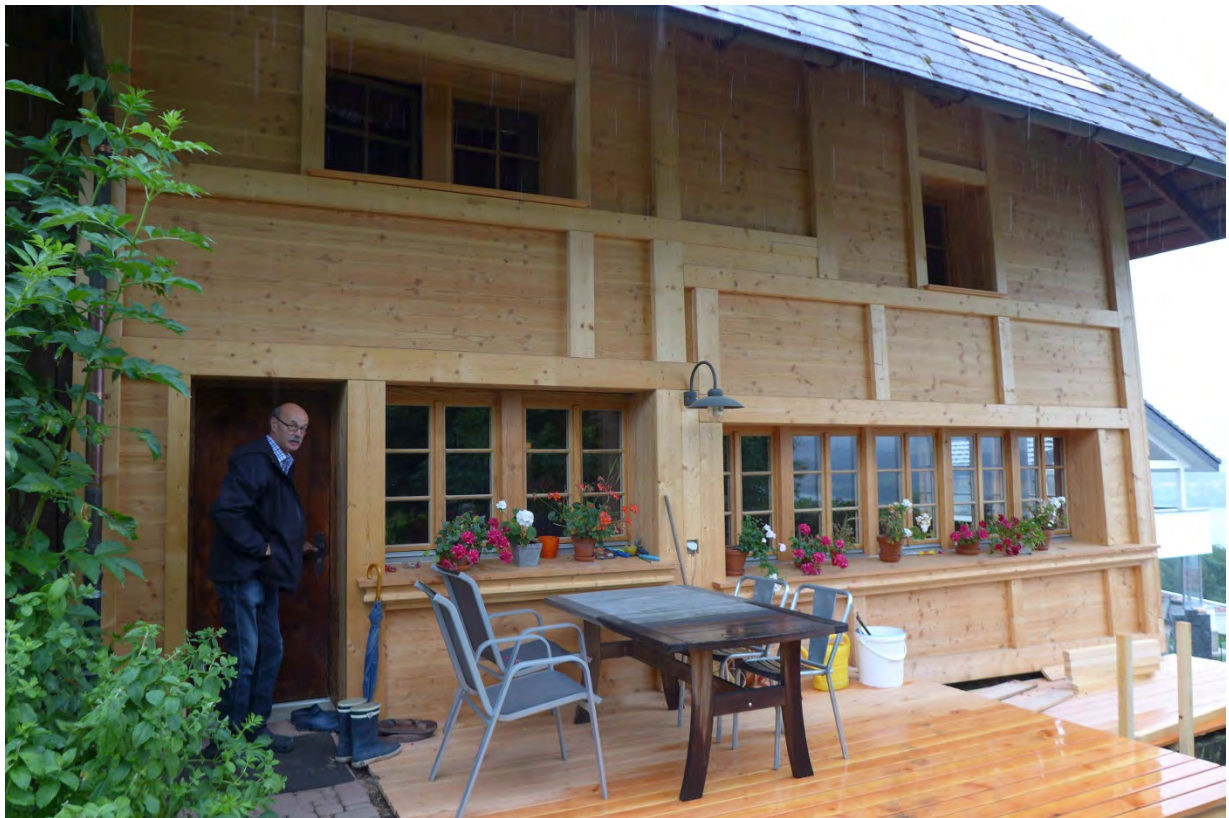
Südliche Stubenfront, mit Wärmedämmung und Holzverkleidung von 2015 (Aufnahme 2016)
