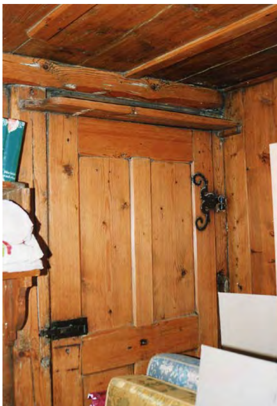
Rahmentür mit Füllungen und Rollbändern (Kurzinventar 1992)
