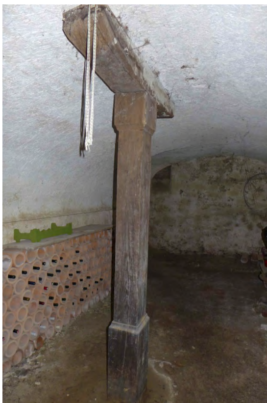
Tonnengewölbter Keller mit Mittelstütze (2016)
