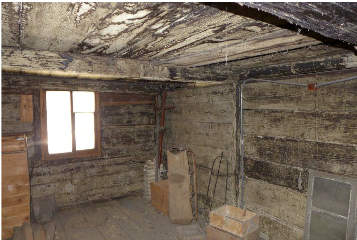
Kammer Obergeschoss, mit Bohlenwänden im Rohbauzustand (2016)
