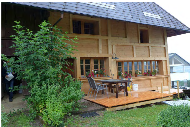
Südliche Stubenfront mit neuer Fassade (Aufnahme 2016)
