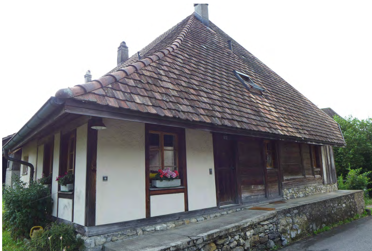
Westliche, strassenseitige Stirnfassade (2016)
