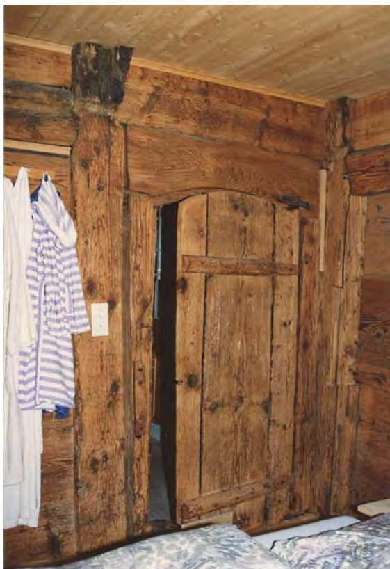
Obergadentür mit stichbogigem Sturz (Kurzinventar 1992)
