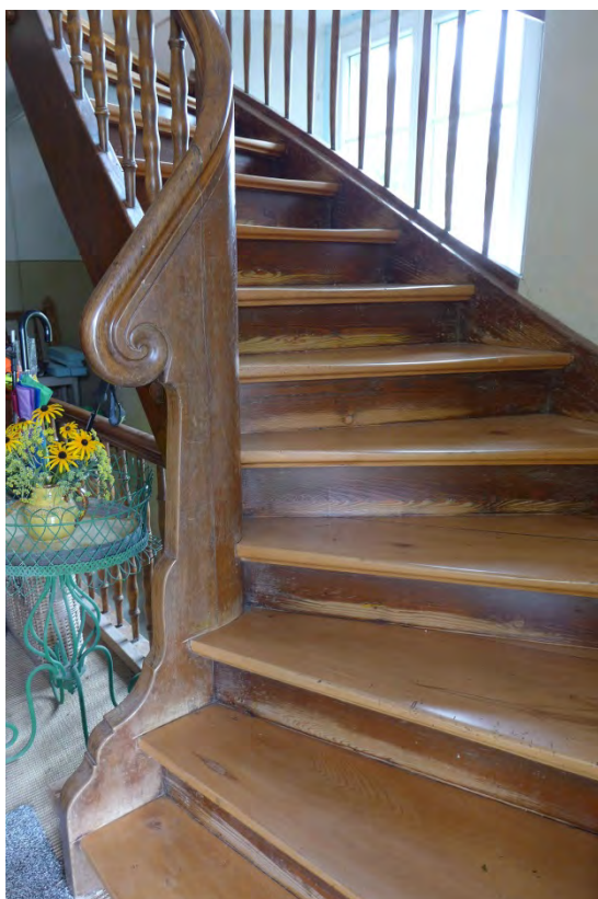
Treppe mit gedrechseltem Geländer und gewundenem Handlauf (2016)
