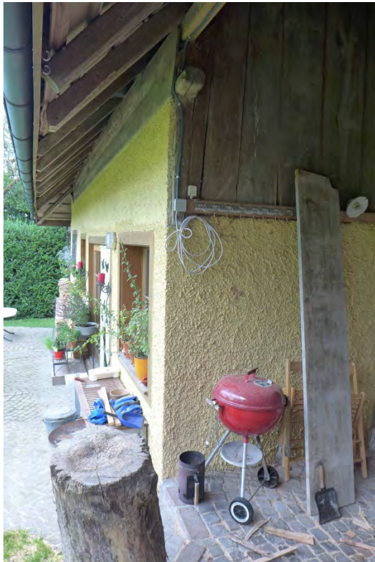
Zugemauerter ehemaliger Hauseingang auf der Rückseite (2016)
