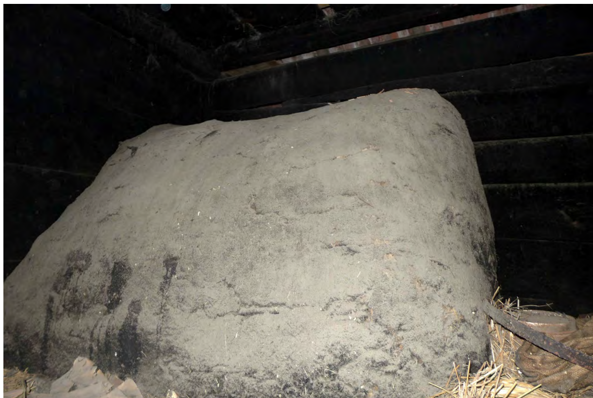
Tonnenförmiger Rauchfang im Obergeschoss (2016)
