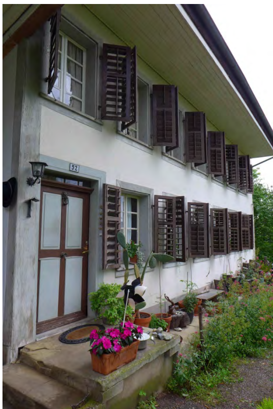
Fassade mit tennseitigem Hauseingang (2016)
