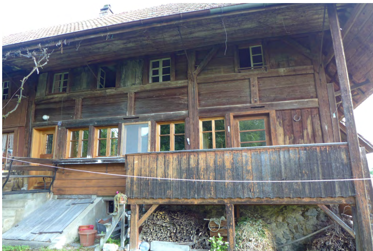
Südliche Stubenfront östlicher Hausteil (2016)
