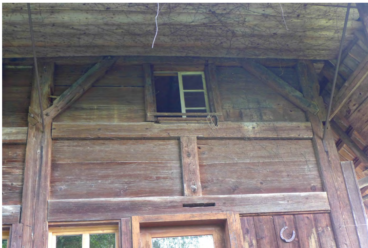
Bohlenwand mit verblatteten Kopfhölzern (2016)
