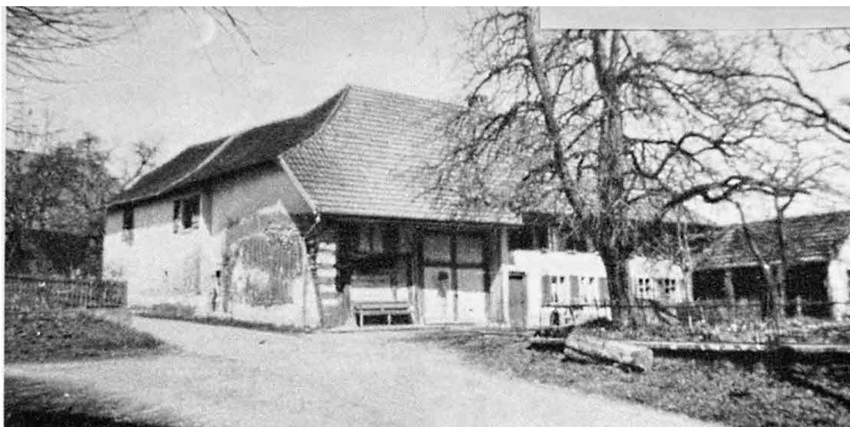
Historische Ansicht des "Alten Bären" auf der gegenüberliegenden Strassenseite (aus: Keller 1963, S. 104)
