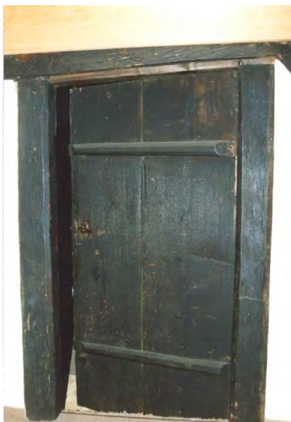
Rauchgeschwärzte Bretttertür im Obergeschoss (Kurzinventar 1992)
