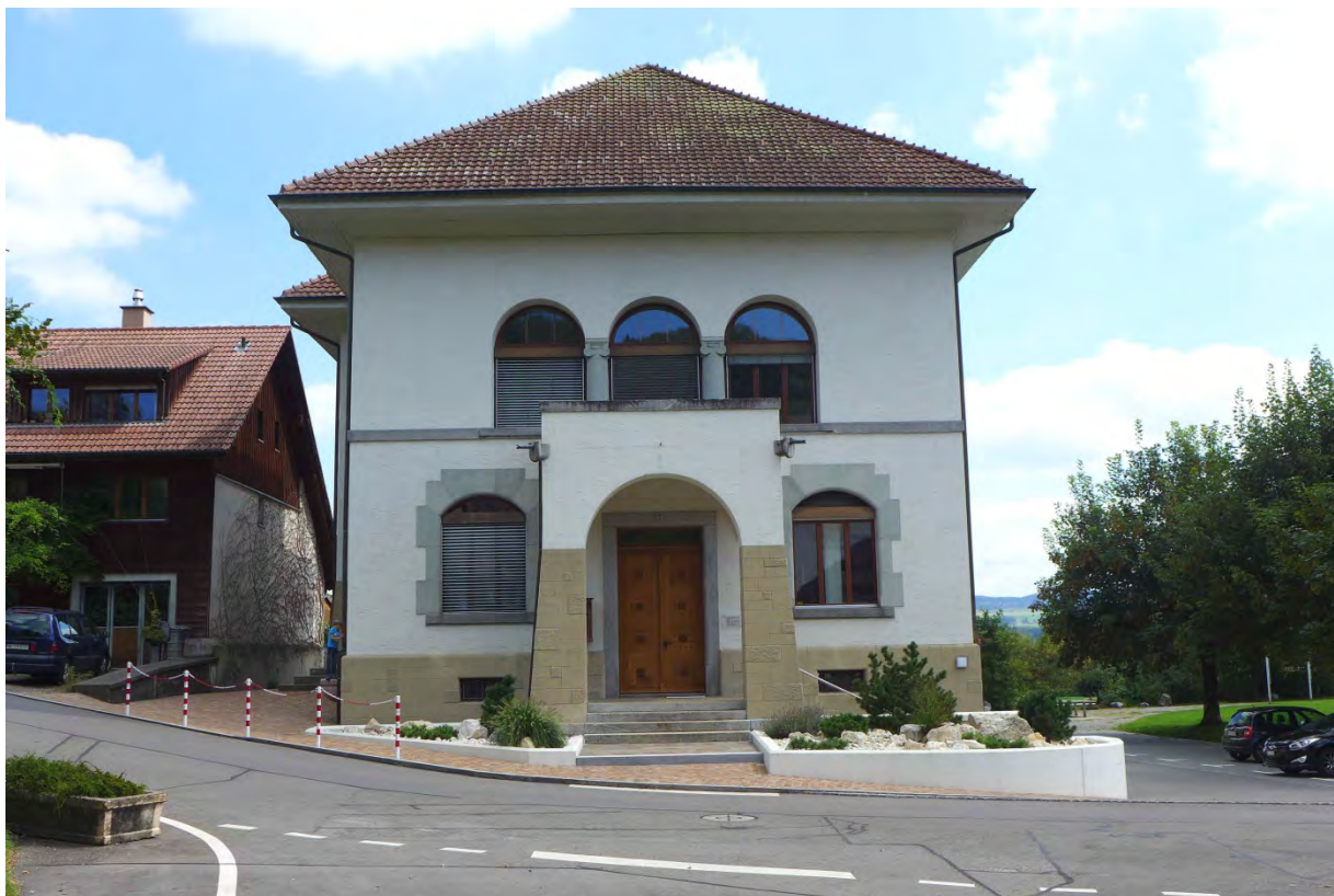
Westliche Eingangsfront mit Portalvorbau (2016)
