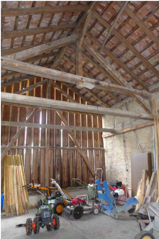
Blick ins Innere, einfache Gerüstbauweise und Dachkonstruktion mit Hängewerk (2016)
