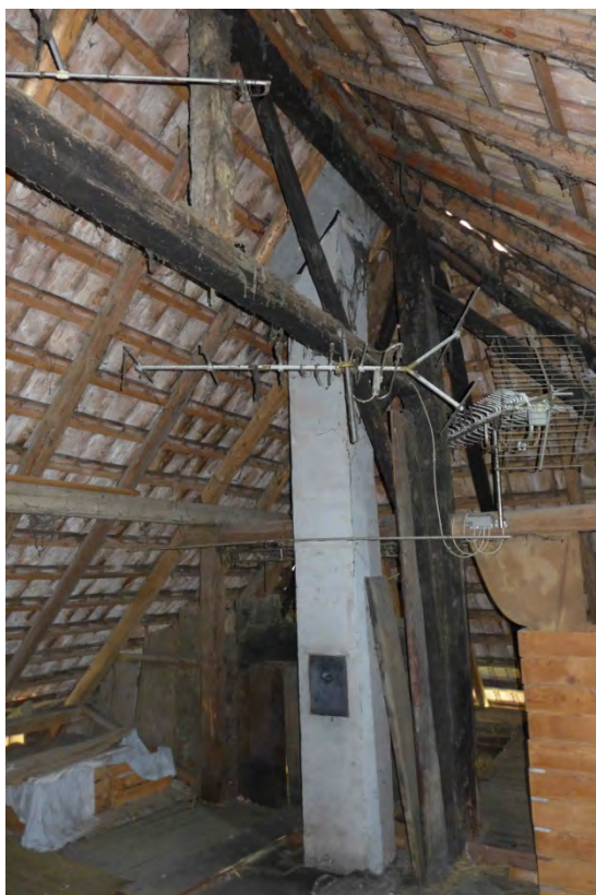
Hochstud-Dachkonstruktion (2016)
