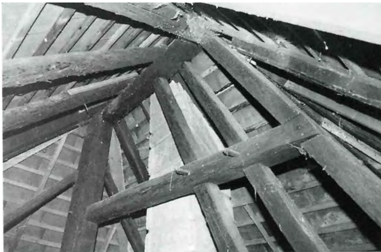
Firstbereich Hochstudkonstruktion (Bauernhausforschung 2000)
