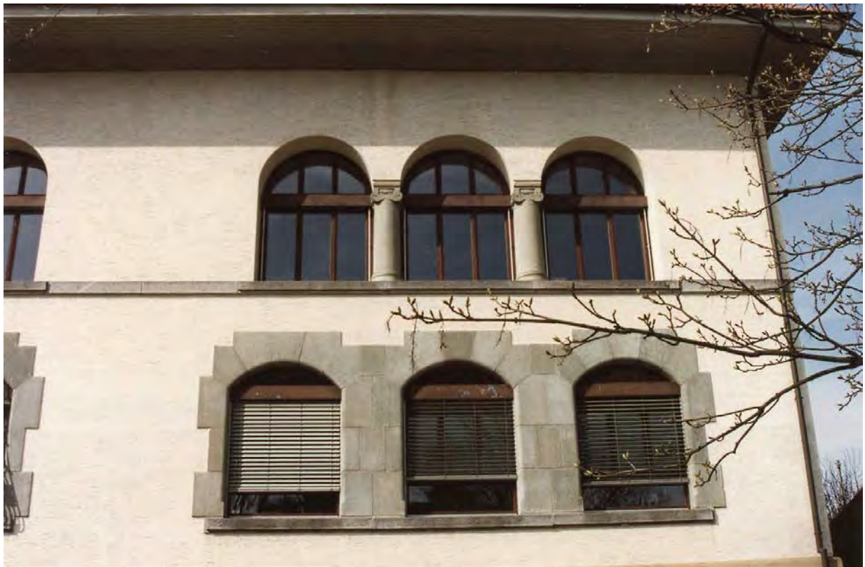
Unterschiedlich ausgebildete Bogenfenster im Parterre und Obergeschoss (2016)
