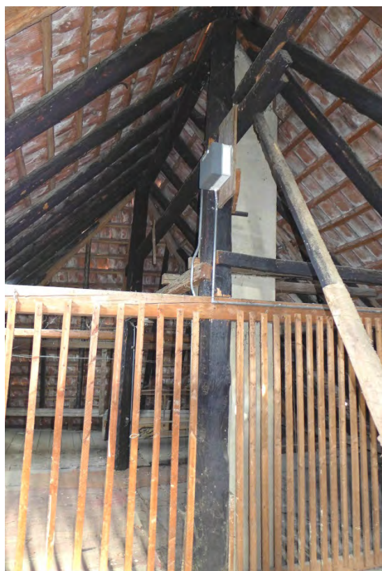
Rauchgeschwärzte Hochstud-Dachkonstruktion (2016)
