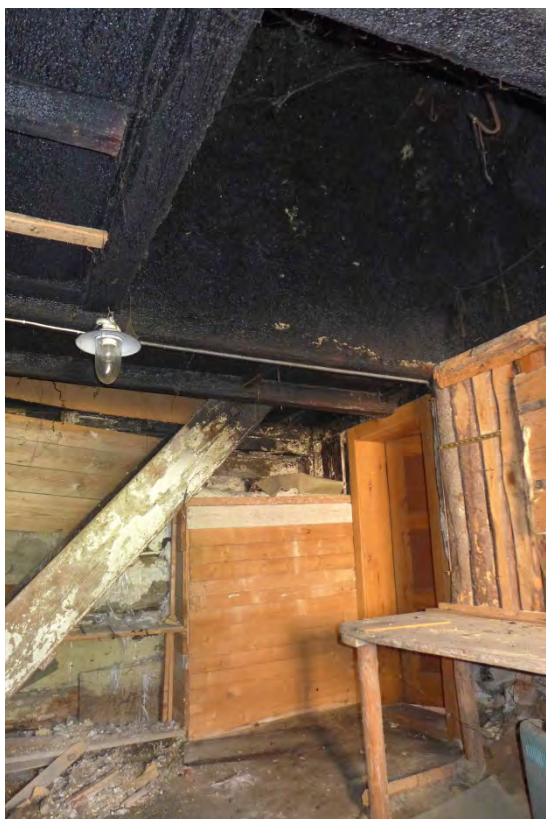
Rauchküche westlicher Hausteil (2016)
