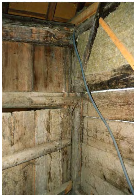
Alte Bohlenständerkonstruktion zwischen Wohnteil und Tenn (Kurzinventar 1992)
