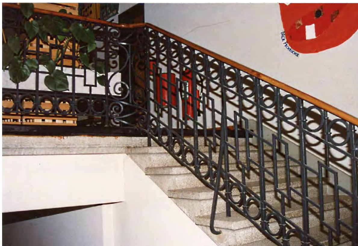
Treppenhaus mit bauzeitlichem Eisengeländer (Kurzinventar 1992)
