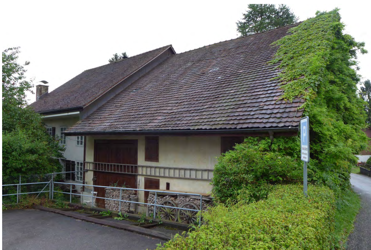
Ansicht rückwärtige Nordfassade (2016)
