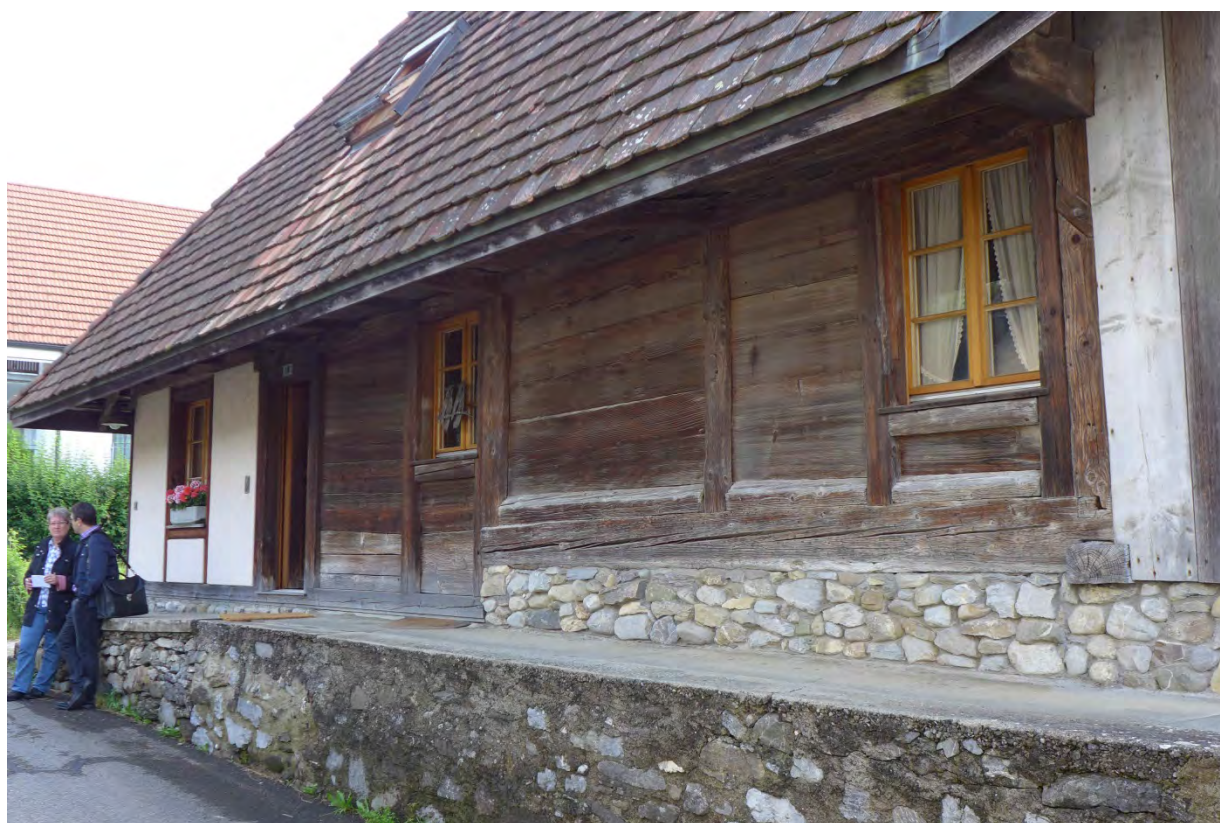
Alte Bohlenständerwand Westfassade (2016)
