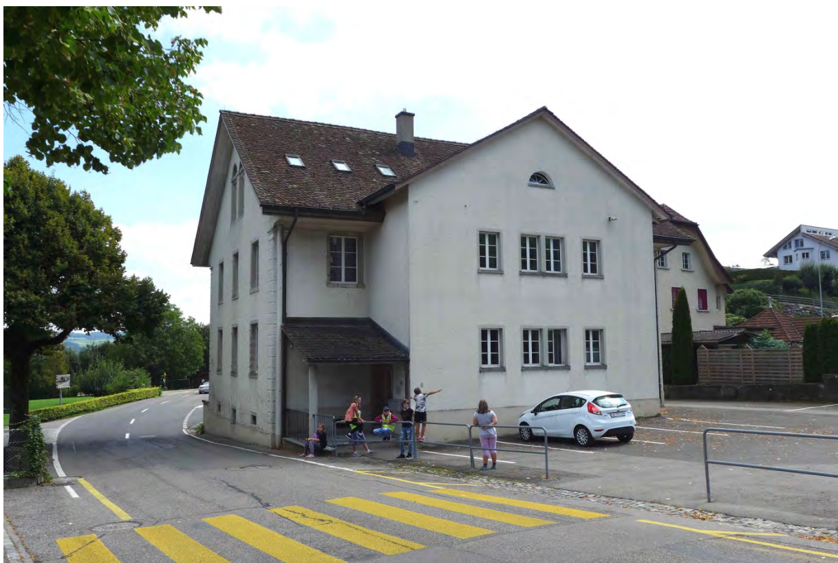
Westliche Rückseite mit jüngerem Quergiebelanbau (2016)
