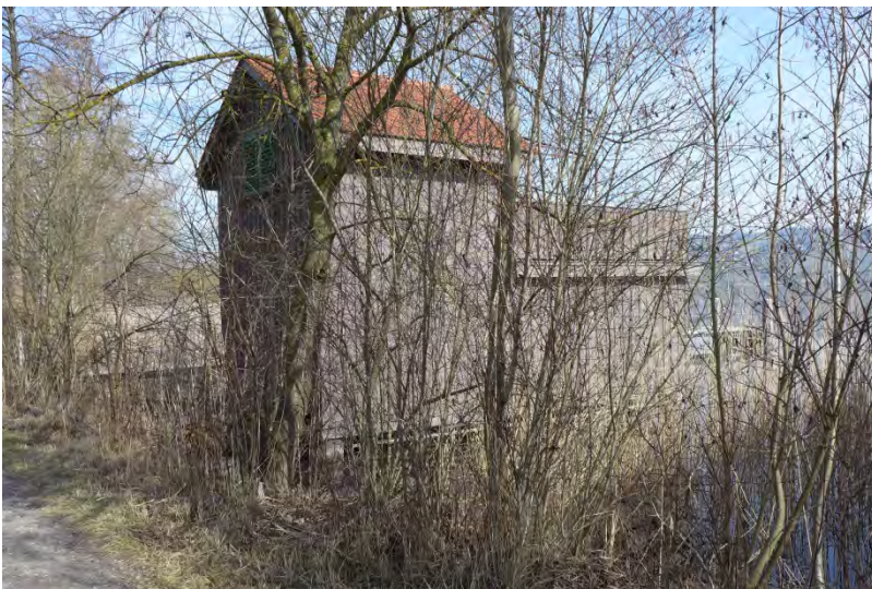
Bootshaus Vers.-Nr. 41, Ansicht von Süden (2017)
