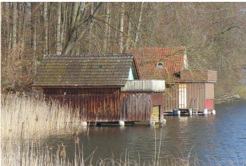
Bootshaus Vers.-Nr. 222, Ansicht von Süden (2017)
