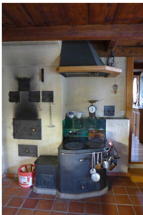
Eiserner Sparherd Küche westlicher Hausteil (2016)
