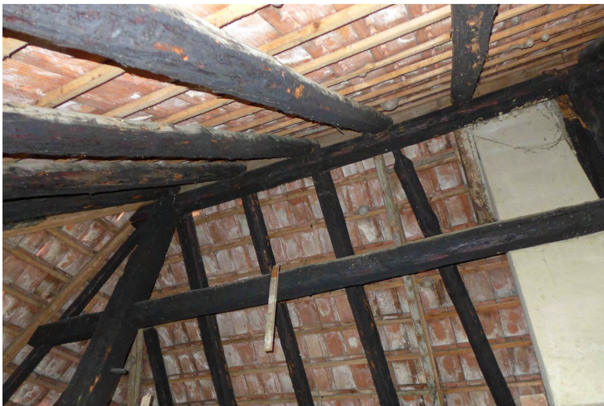
Firstbereich Hochstudkonstruktion (2016)
