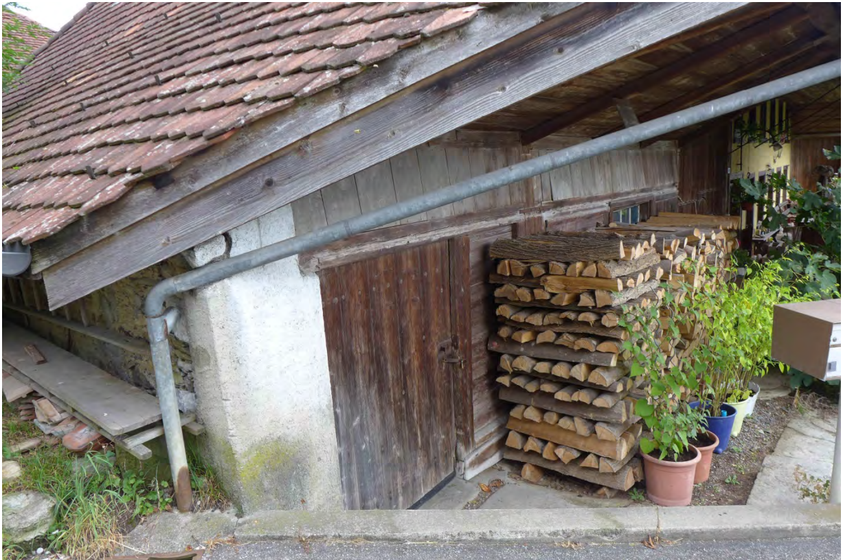
Scheunenteil mit mächtiger Bruchsteinmauer und älteren Holzteilen (2016)
