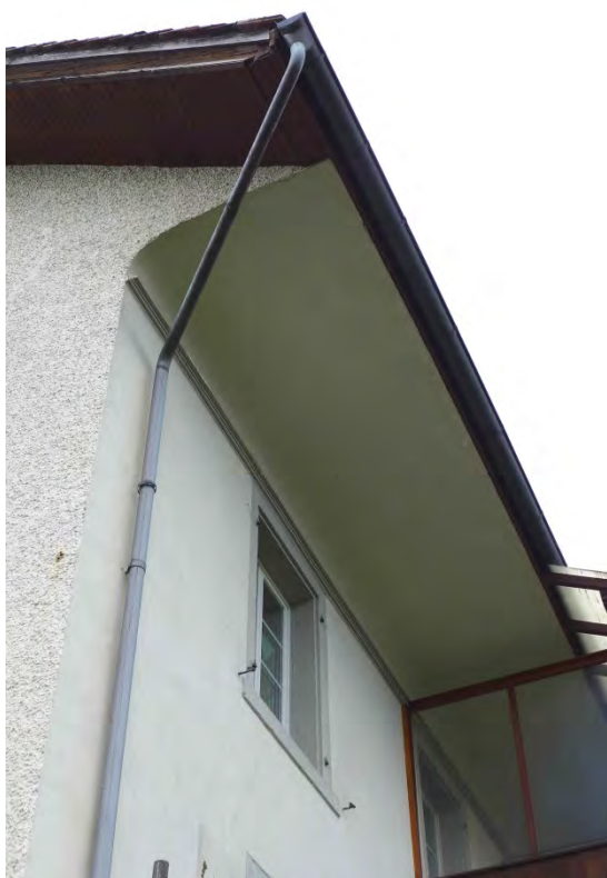
Taufseitiger Fassadenabschluss mit grosser Hohlkehle (2016)
