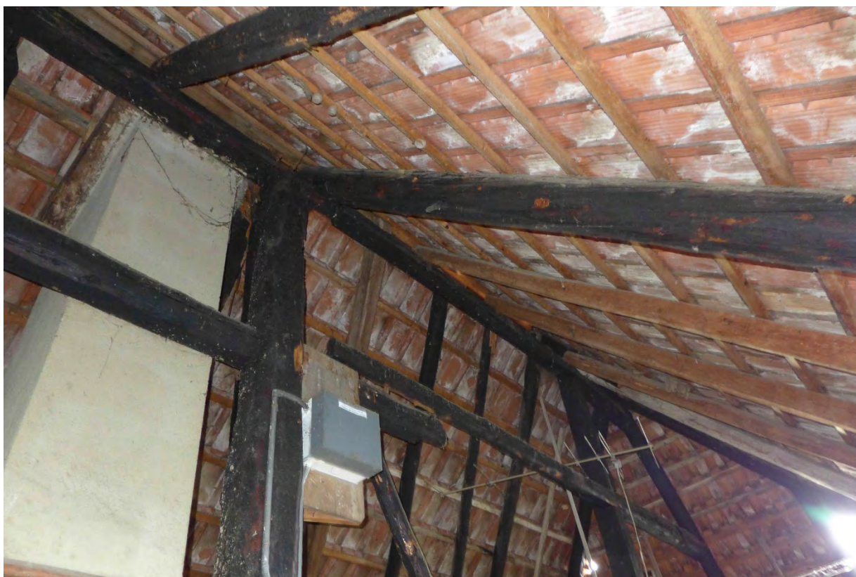
Firstbereich Hochstudkonstruktion, Ansatzstelle nach Osten (2016)
