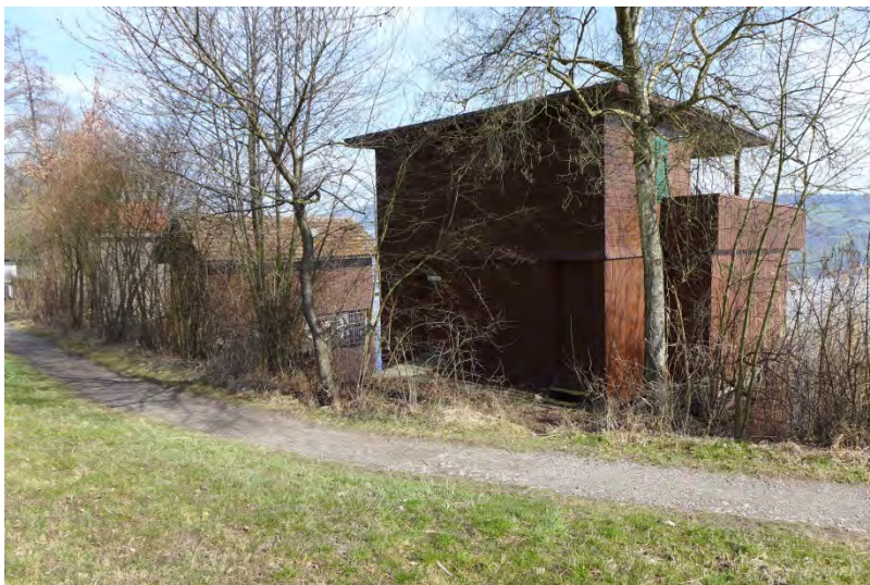
Bootshaus Vers.-Nr. 236, Ansicht von Süden (2017)
