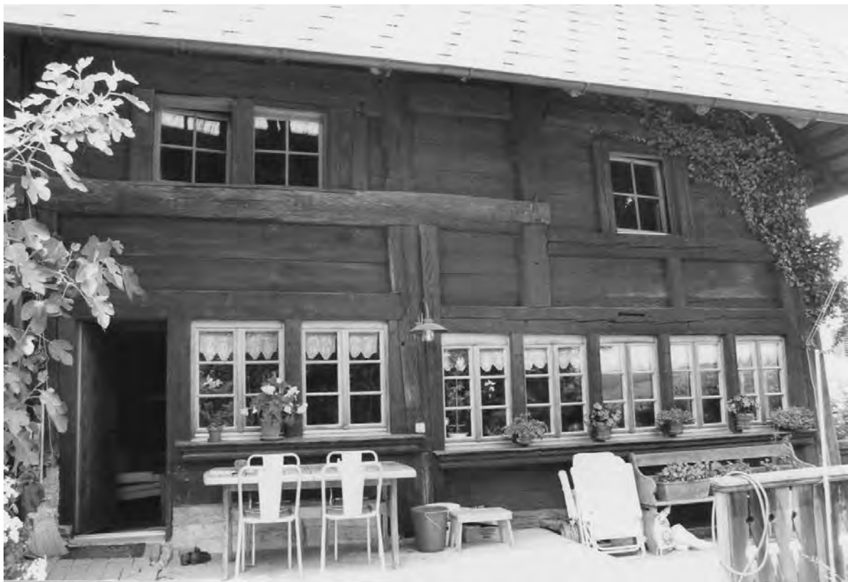
Südliche Stubenfront, Zustand nach der Restaurierung von 1981 (Aufnahme Bauernhausforschung 1999)
