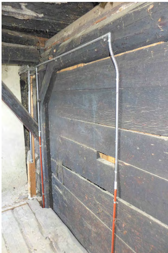
Ständergerüst mit liegenden Bohlen und verblattetem Kopfholz (2016)
