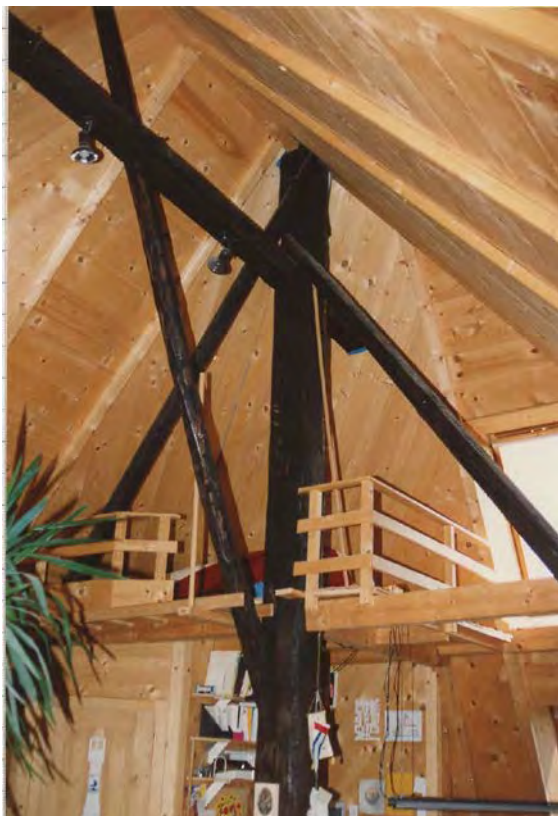
Hochstudkonstruktion im ausgebauten Dachgeschoss (Kurzinventar 1992)
