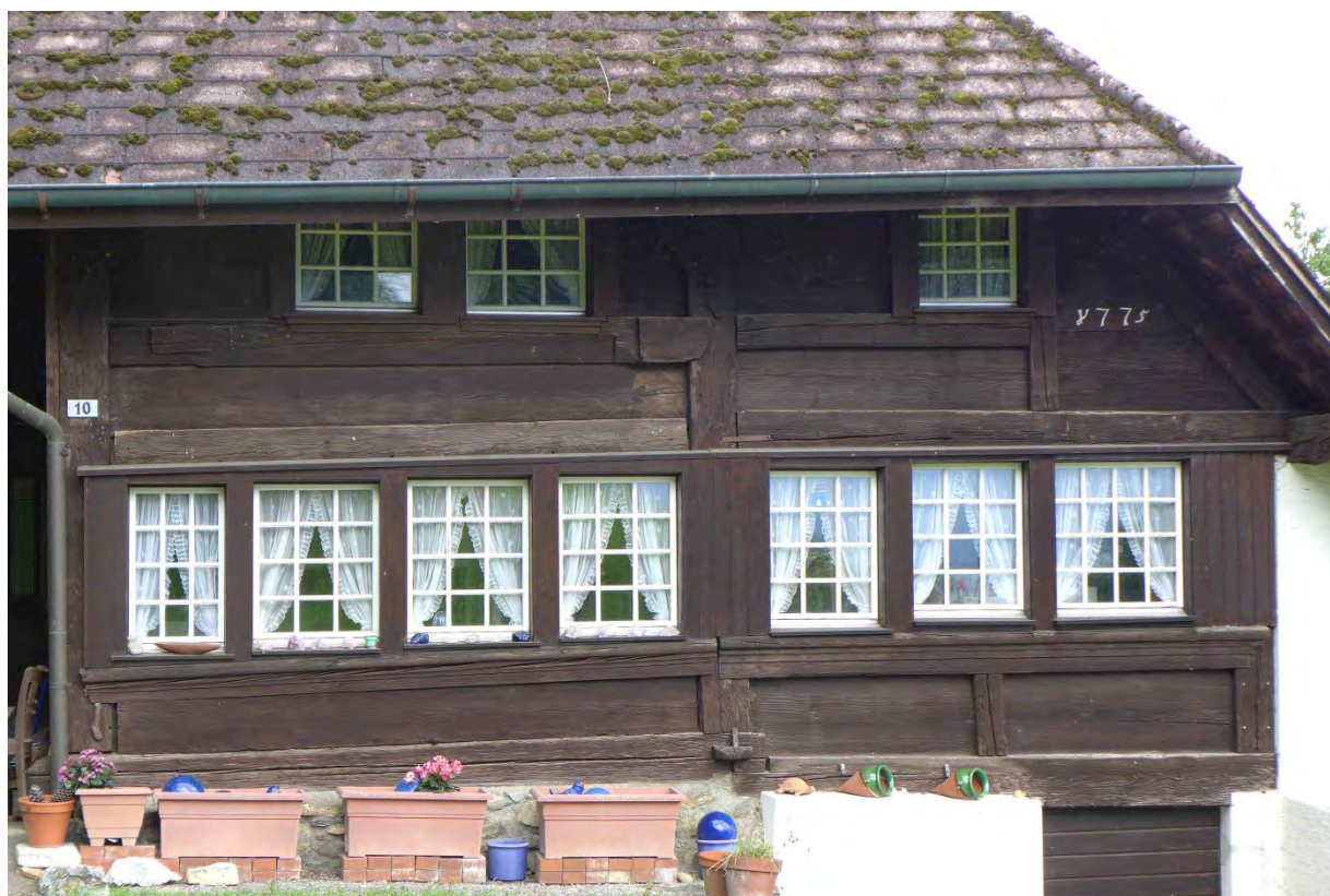
Bohlenständerkonstruktion an der südlichen Stubenfront (2016)
