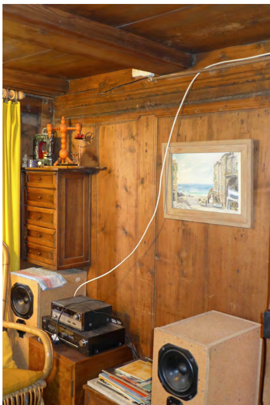
Trennwand mit stehenden Bohlen (2016)
