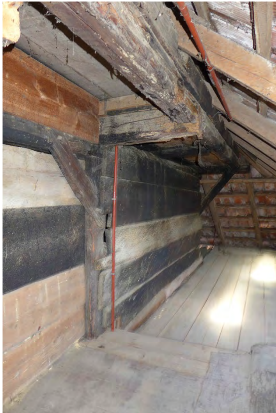
Bohlenwand im rückwärtigen Hausbereich, ehemalige Aussenwand (2016)
