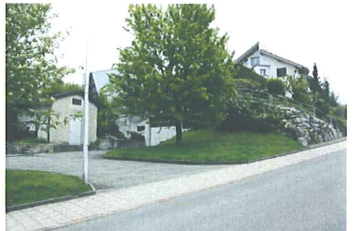
Trafostation und Zufahrt bestehende Tiefgarage
