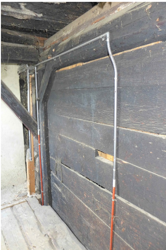
Ständergerüst mit liegenden Bohlen und verblattetem Kopfholz (2016)
