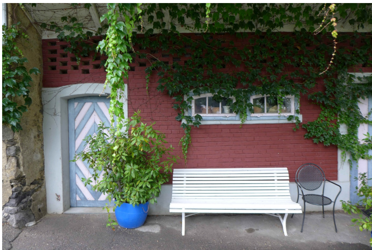
Stallfront aus Backsteinmauerwerk, frühes 20. Jh. (2016)
