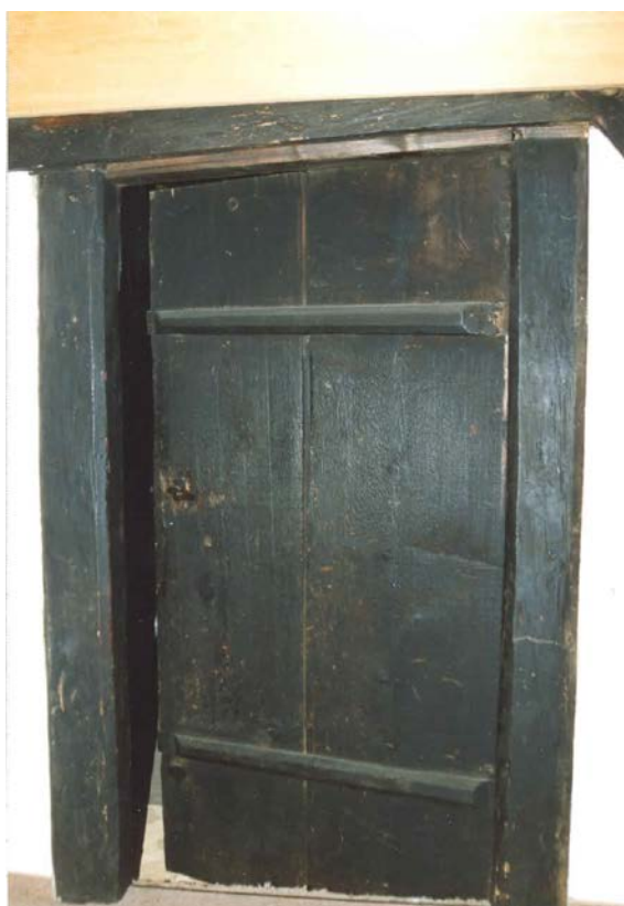
Rauchgeschwärzte Bretttertür im Obergeschoss (Kurzinventar 1992)
