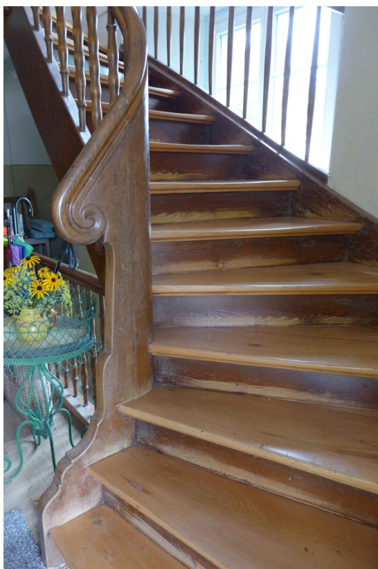
Treppe mit gedrechseltem Geländer und gewundenem Handlauf (2016)
