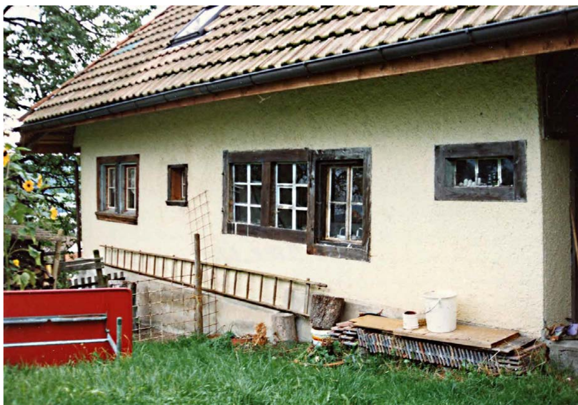
Hausrückseite, vor dem Umbau (Kurzinventar 1992)
