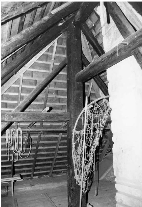
Einer-Hochstud (Bauernhausforschung 2000)
