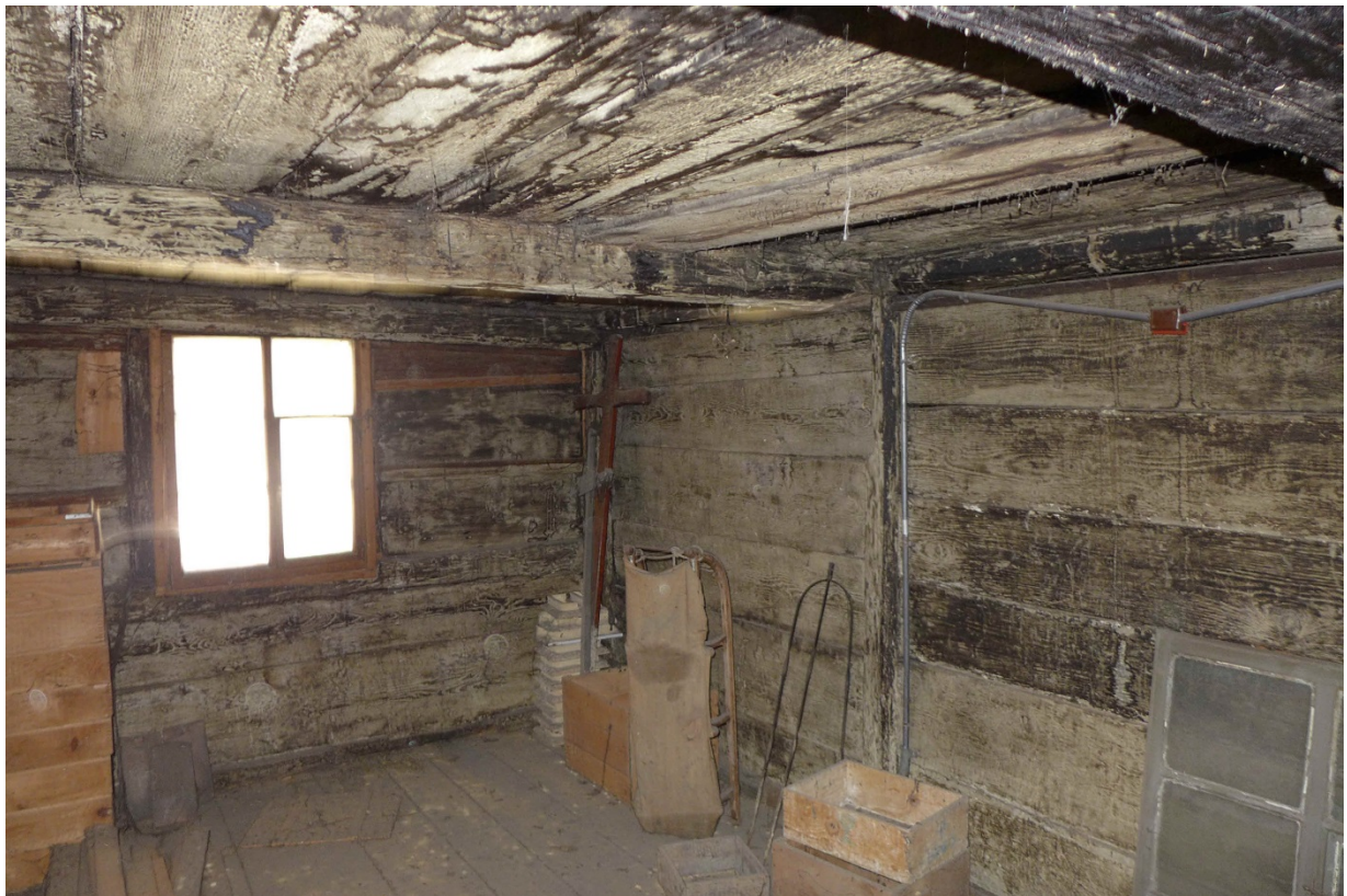
Kammer Obergeschoss, mit Bohlenwänden im Rohbauzustand (2016)
