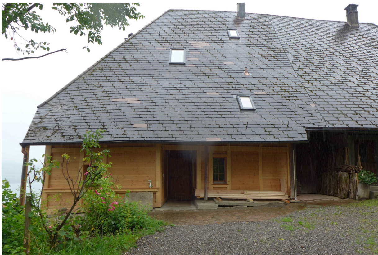
Nördliche Trauffassade nach den baulichen Massnahmen von 2015 (Aufnahme 2016)
