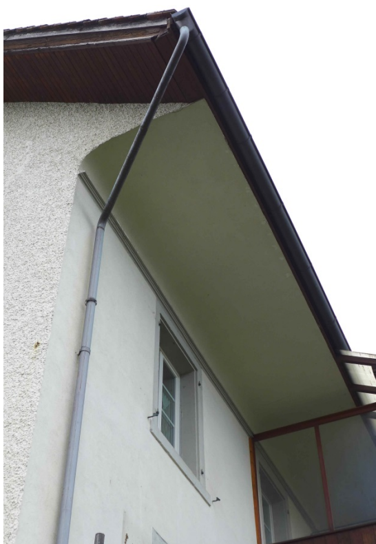
Taufseitiger Fassadenabschluss mit grosser Hohlkehle (2016)
