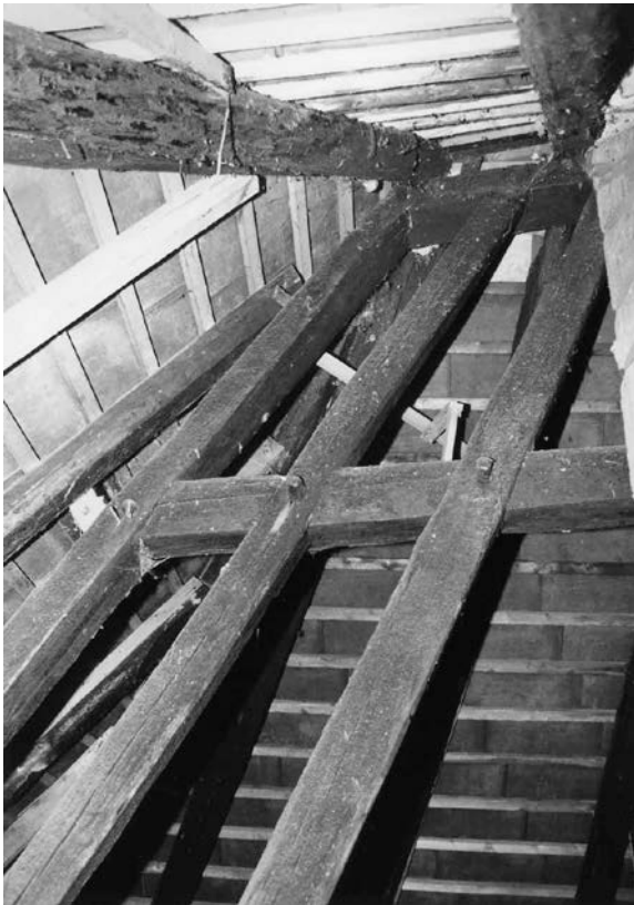
Dachkonstruktion von 1599, mit parallel geführten Windstreben (Bauernhausforschung 2000)
