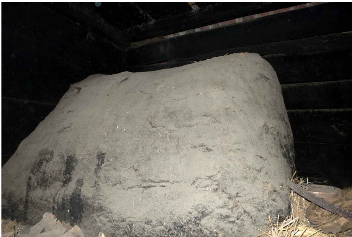
Tonnenförmiger Rauchfang im Obergeschoss (2016)
