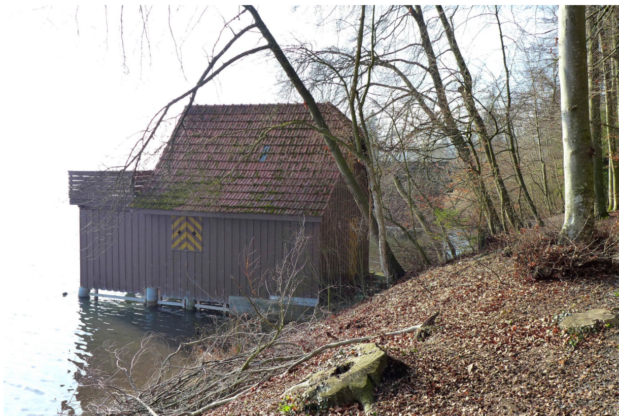
Uferseitige Ansicht von Norden (2017)
