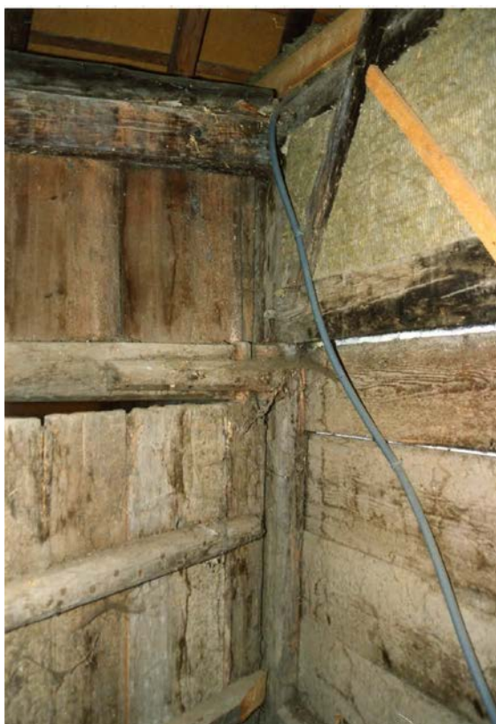
Alte Bohlenständerkonstruktion zwischen Wohnteil und Tenn (Kurzinventar 1992)
