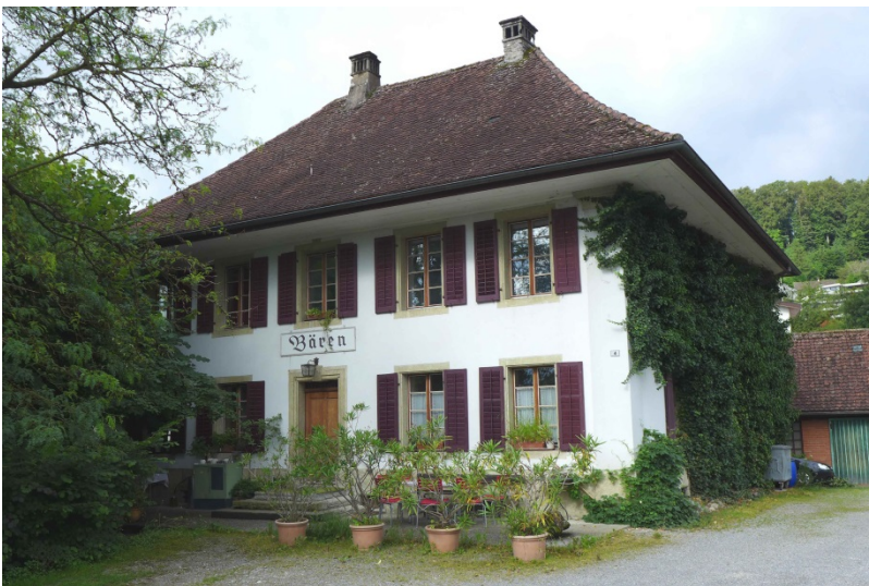
Ansicht der Schauffront von Osten (2016)
