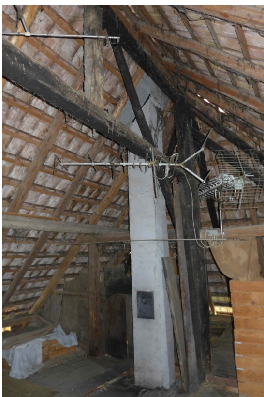
Hochstud-Dachkonstruktion (2016)
