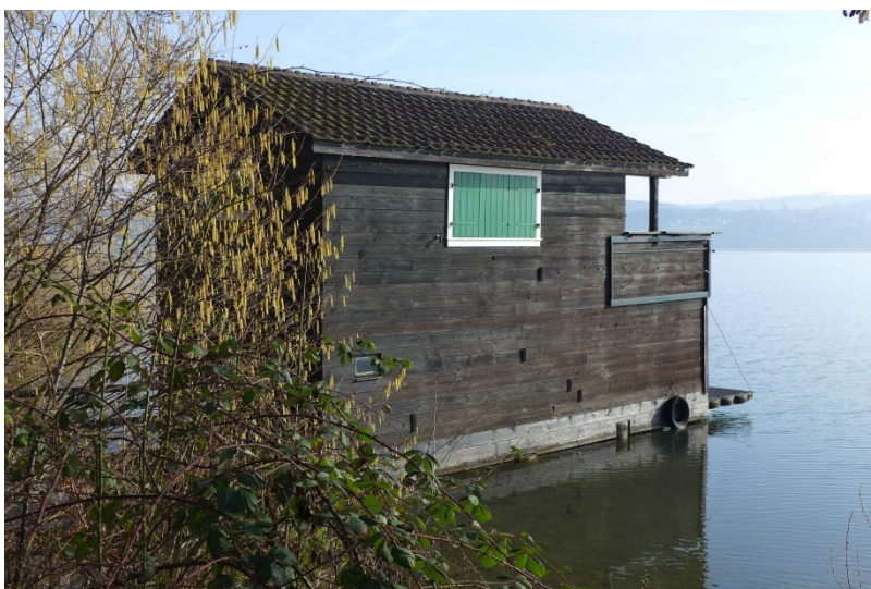
Bootshaus Vers.-Nr. 223, Ansicht von Süden (2017)
