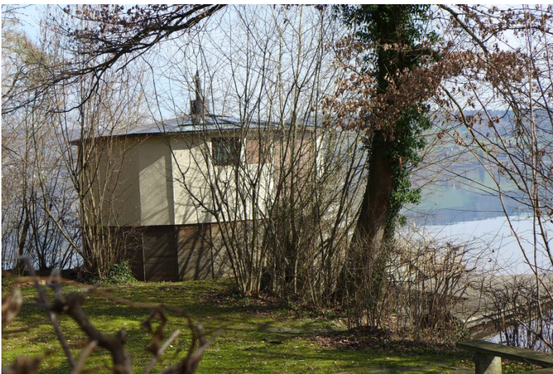
Wochenendhaus Vers.-Nr. 226, Ansicht vom Ufer (2017)
