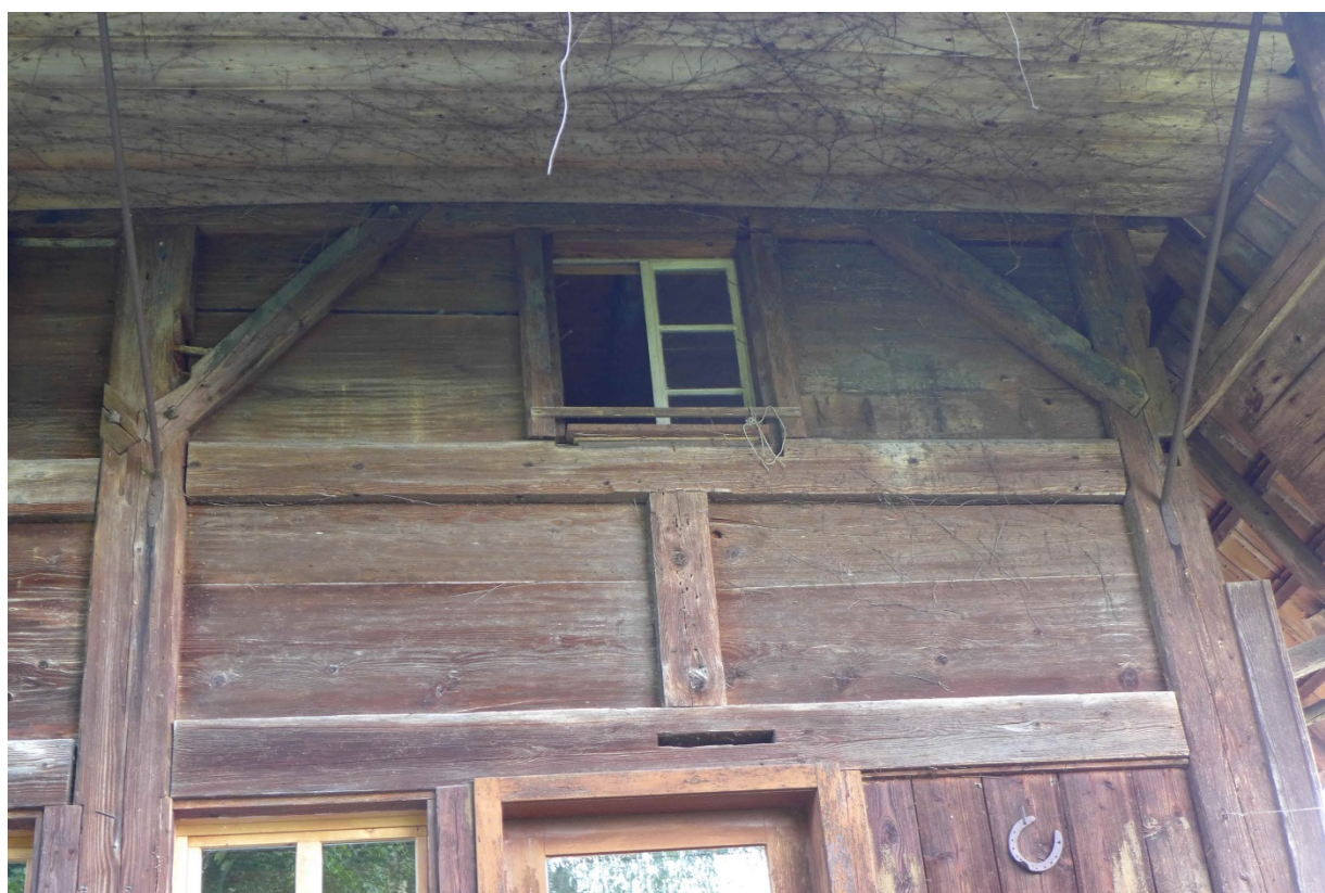
Bohlenwand mit verblatteten Kopfhölzern (2016)
