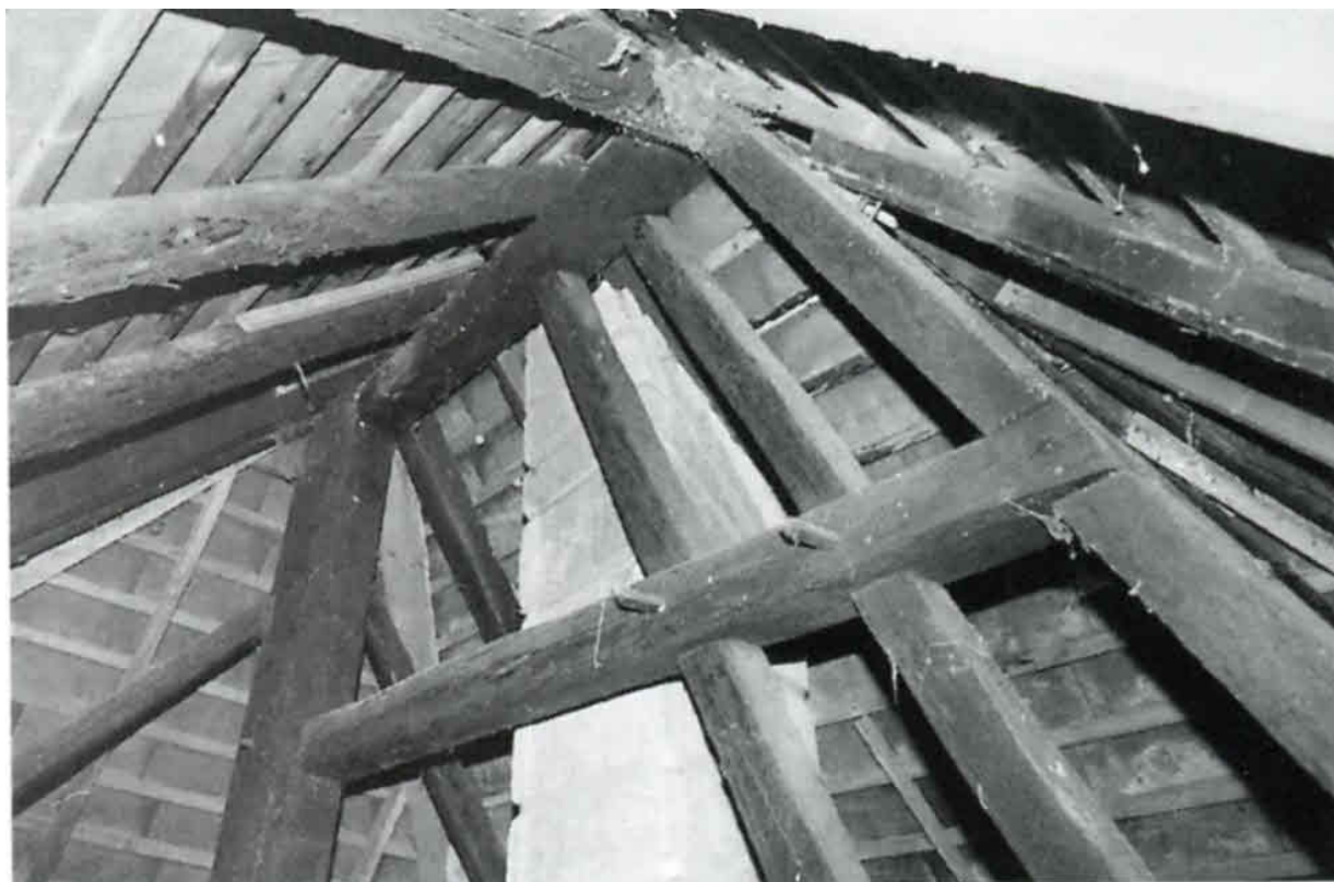
Firstbereich Hochstudkonstruktion (Bauernhausforschung 2000)
