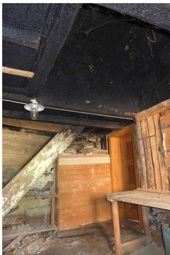
Rauchküche westlicher Hausteil (2016)
