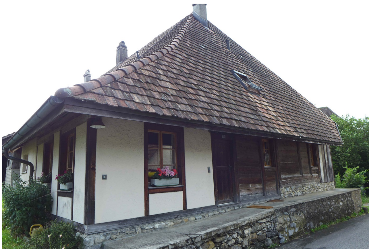
Westliche, strassenseitige Stirnfassade (2016)
