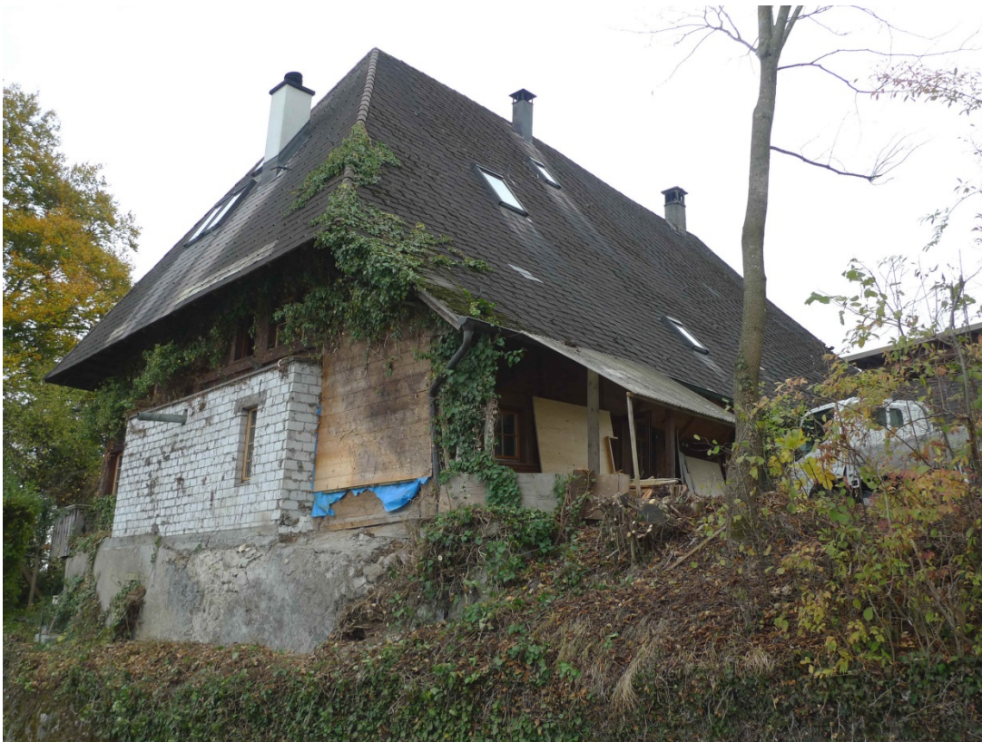
Östliche Stirnfassade, Zustand vor den baulichen Massnahmen von 2015 (Aufnahme 2016)
