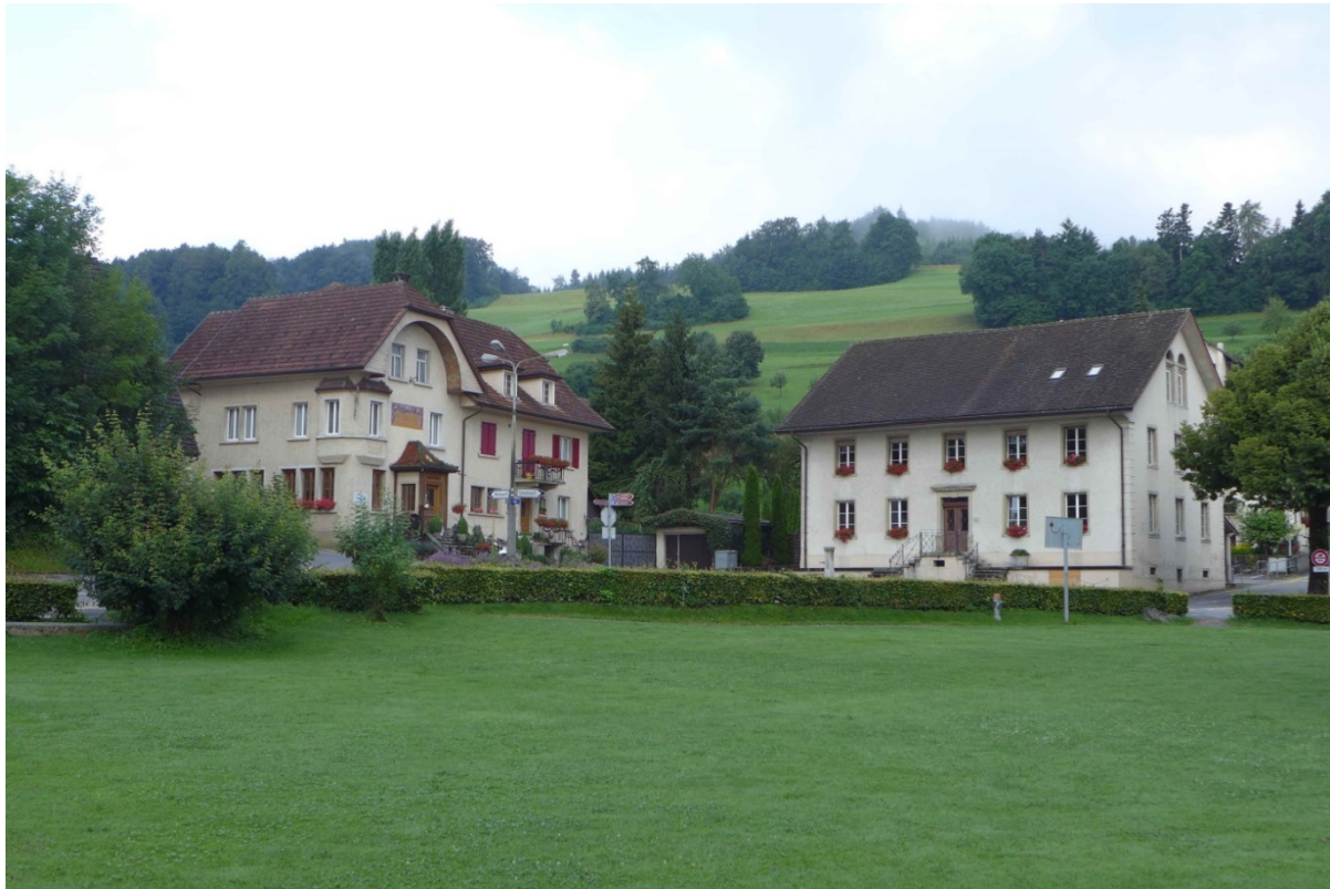
Situationsansicht von Nordosten (2016)
