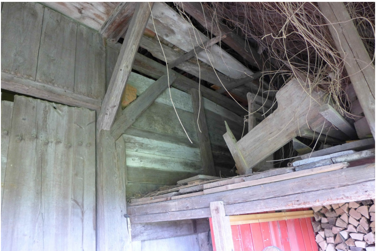
Alte Bohlenständerwand auf der Rückseite des Scheunenteils (2016)
