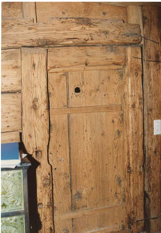
Obergadentür mit kielbogenartigem Sturz (Kurzinventar 1992)
