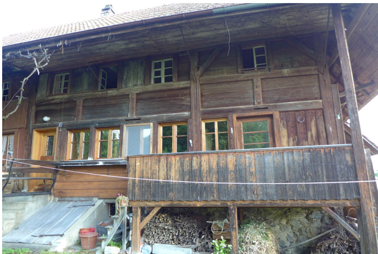
Südliche Stubenfront östlicher Hausteil (2016)
