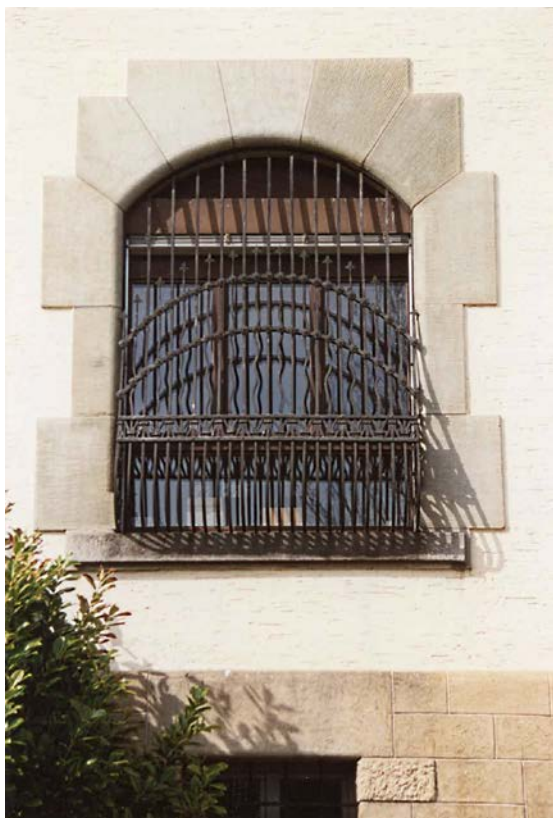
Vergitterte Fensteröffnung an der östlichen Eingangsfront (Kurzinventar 1992)
