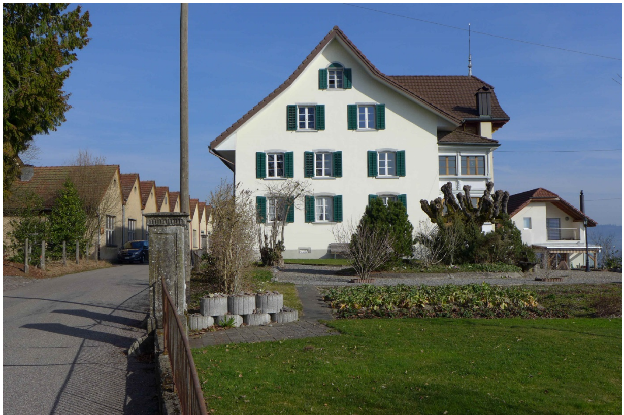
Situationsansicht mit Fabrikbauten im Hintergrund (2017)
