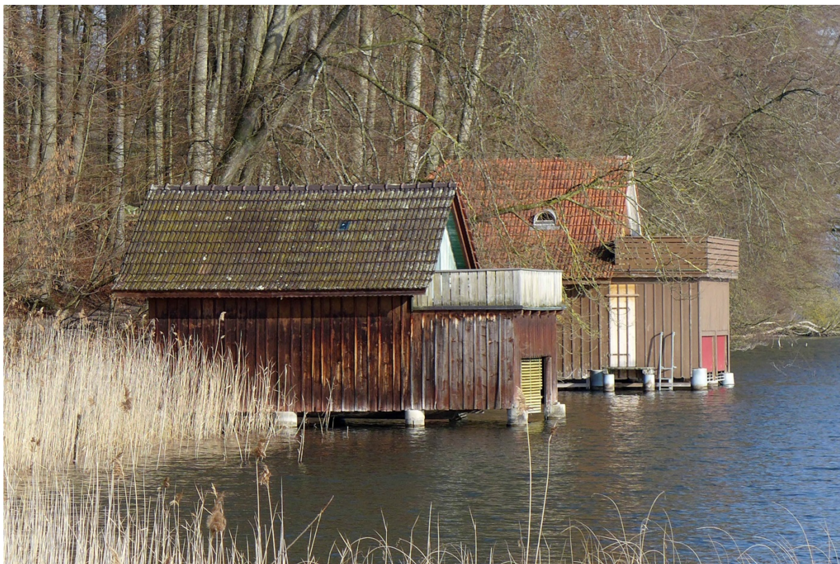
Ansicht des Bootshauses (hinten) von Süden (2017)
