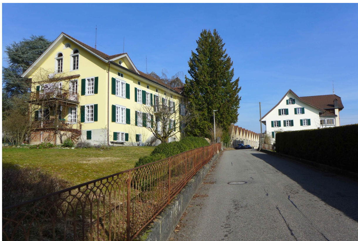
Situationsansicht von Süden, mit älterem Fabrikantenwohnhaus Obere Wanne 39 (BIW921)
