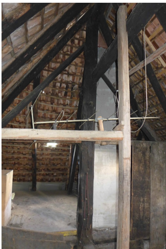
Rauchgeschwärzte Hochstud-Dachkonstruktion (2016)
