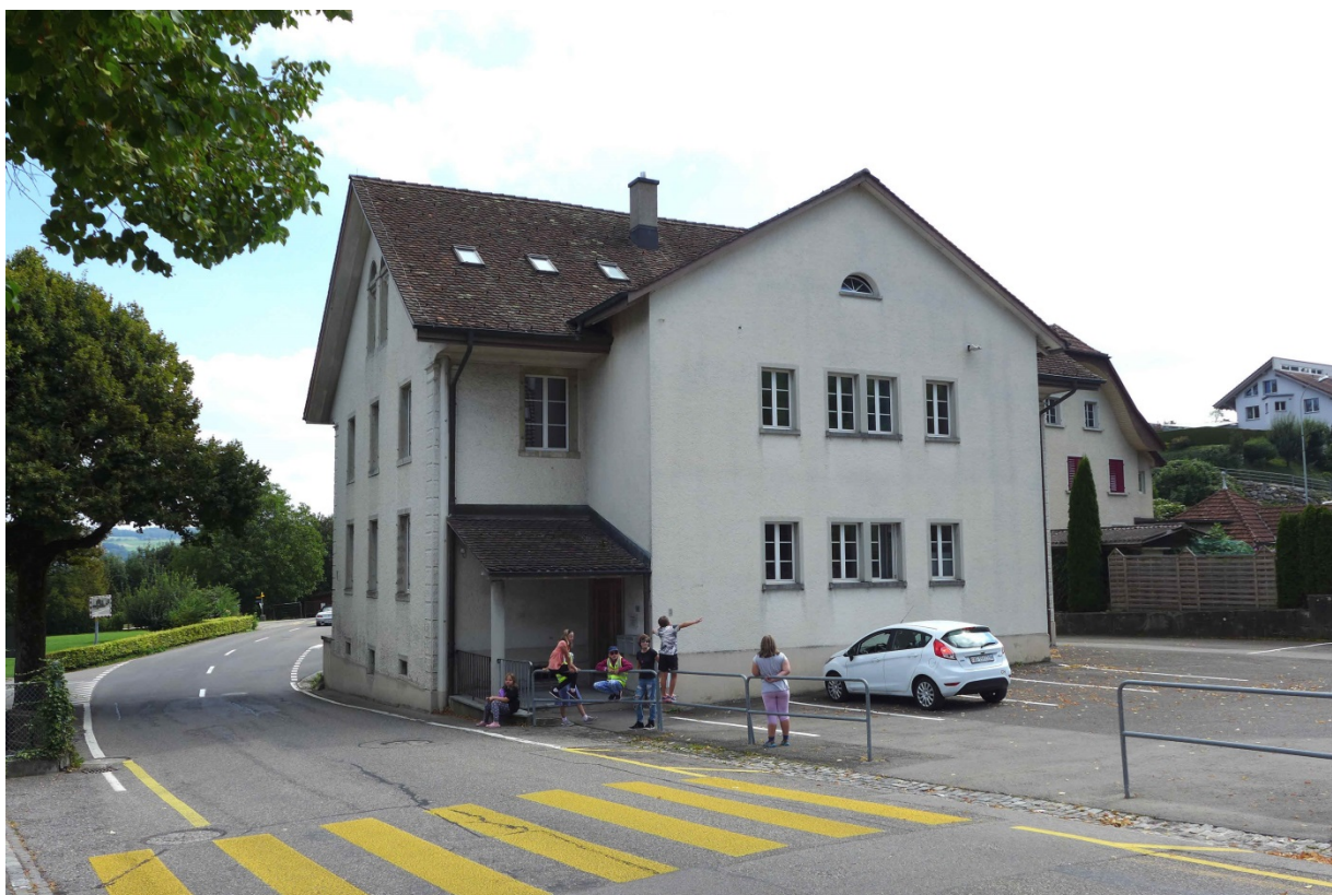
Westliche Rückseite mit jüngerem Quergiebelanbau (2016)
