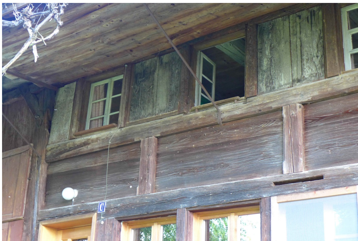
Detail Bohlenwand Obergeschoss (2016)
