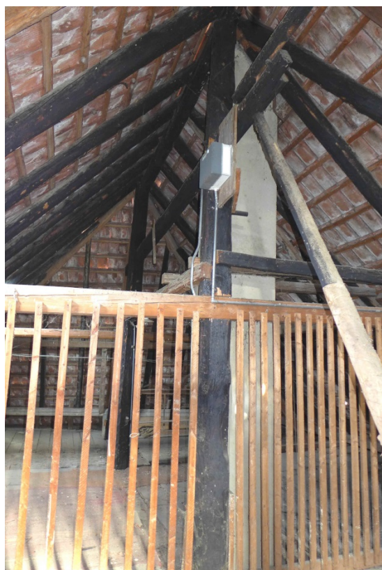
Rauchgeschwärzte Hochstud-Dachkonstruktion (2016)
