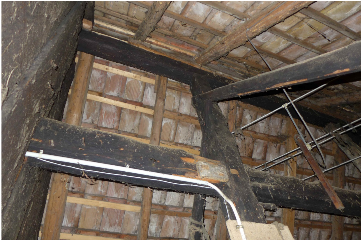
Detail Hochstud-Dachkonstruktion (2016)
