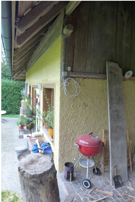
Zugemauerter ehemaliger Hauseingang auf der Rückseite (2016)
