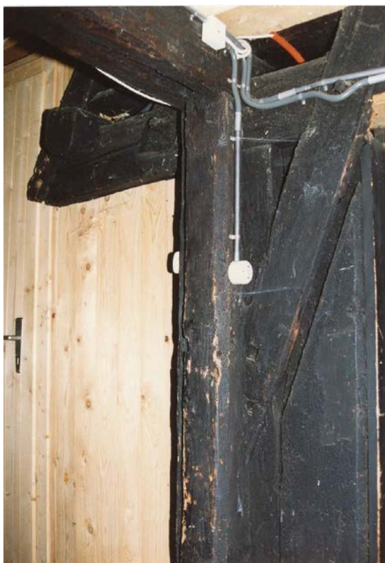
Detail Bohlenwand mit verblatteter Strebe (Kurzinventar 1992)
