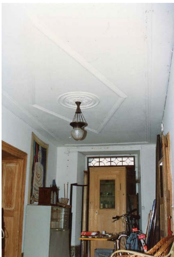
Mittelgang mit Stuckdecke (Kurzinventar 1992)
