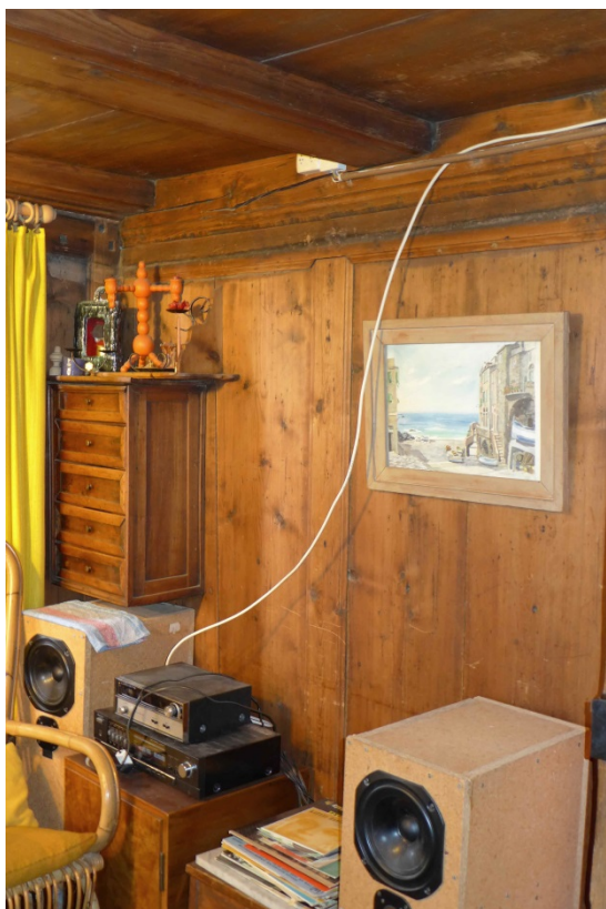
Trennwand mit stehenden Bohlen (2016)
