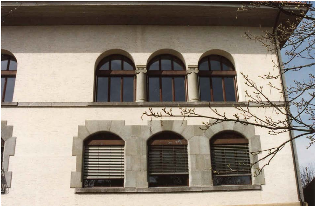
Unterschiedlich ausgebildete Bogenfenster im Parterre und Obergeschoss (2016)
