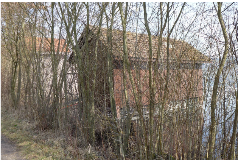
Bootshaus Vers.-Nr. 426, Ansicht von Süden (2017)
