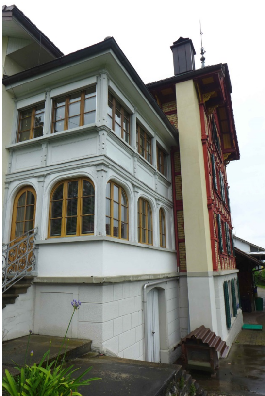
Ostseitiger Laubenanbau von 1894 (2016)
