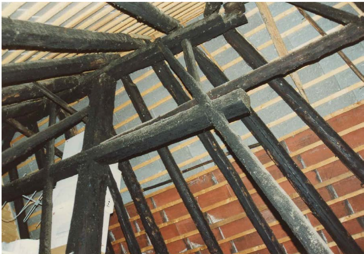
Ansatzpunkt Dachkonstruktion (Kurzinventar 1992)
