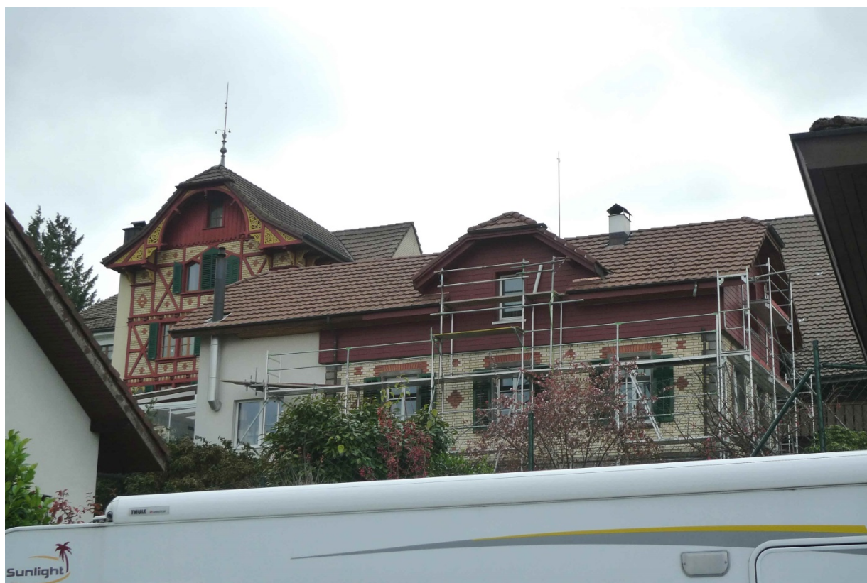
Östlicher Quergiebelanbau aus der Zeit um 1900 (2016)
