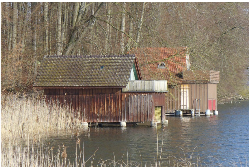
Bootshaus Vers.-Nr. 222, Ansicht von Süden (2017)
