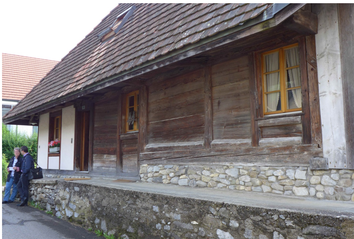
Alte Bohlenständerwand Westfassade (2016)
