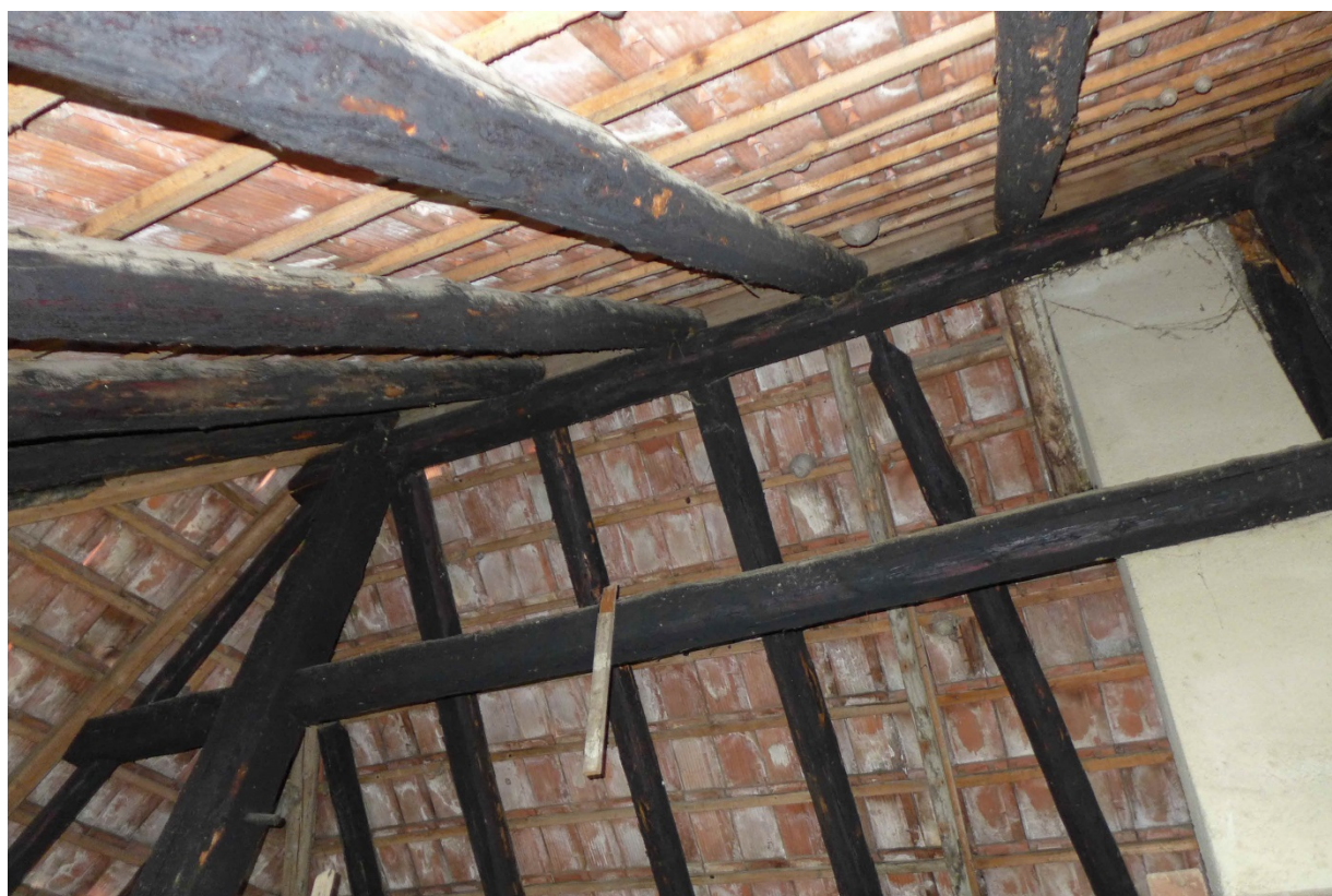
Firstbereich Hochstudkonstruktion (2016)
