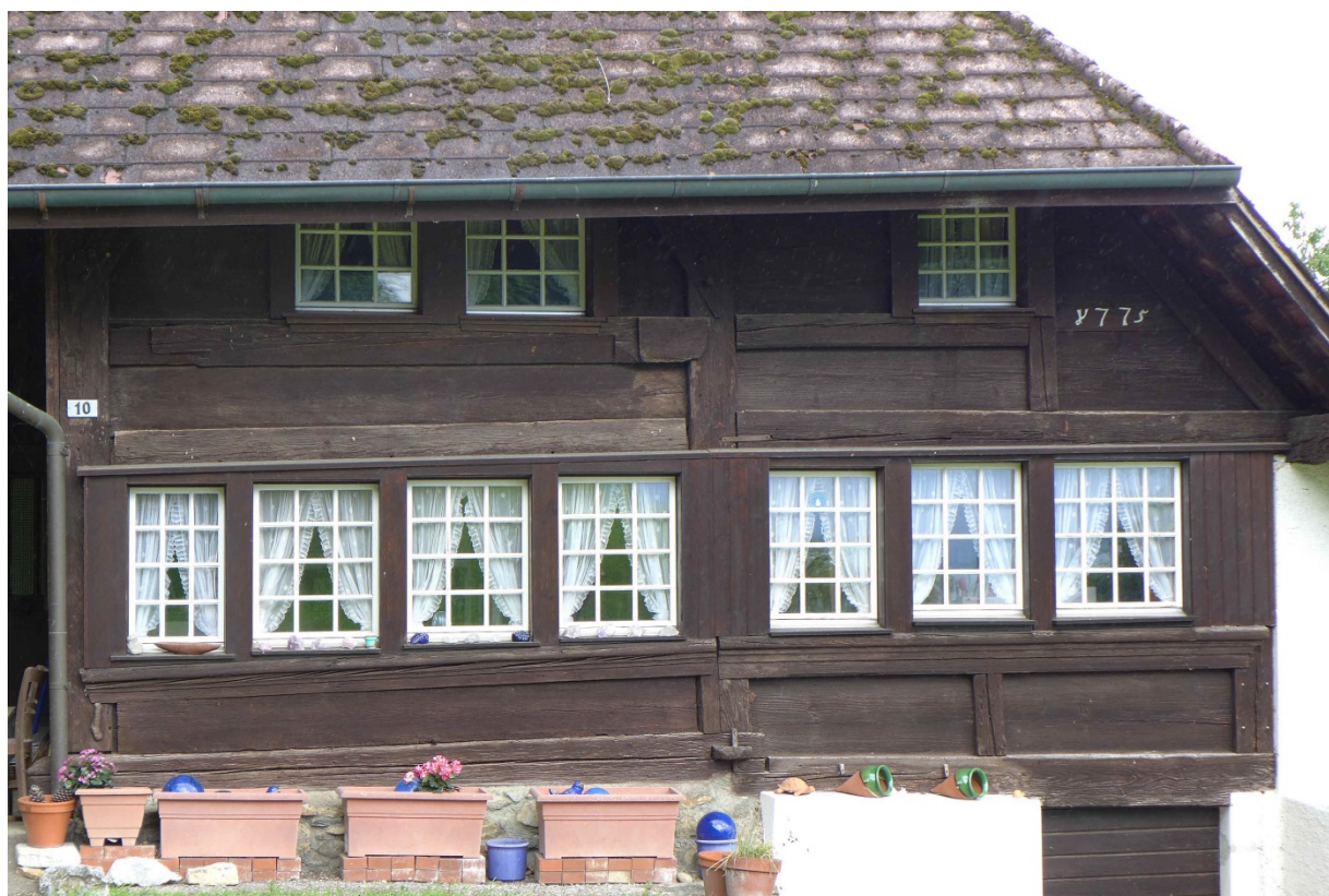
Bohlenständerkonstruktion an der südlichen Stubenfront (2016)
