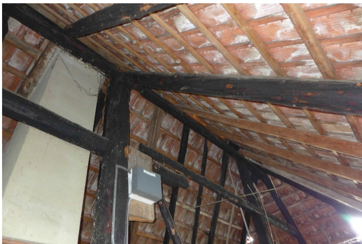
Firstbereich Hochstudkonstruktion, Ansatzstelle nach Osten (2016)
