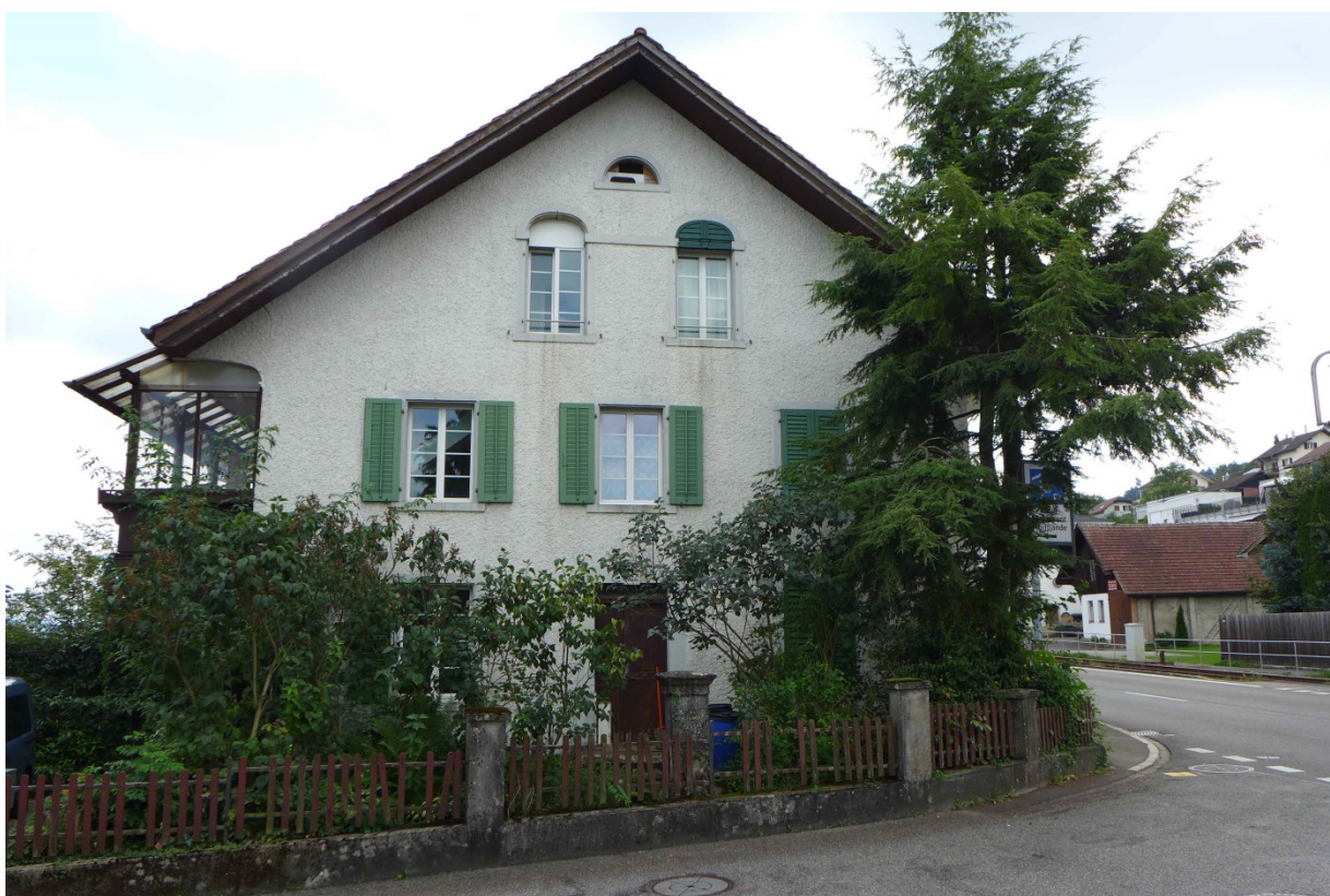
Nördliche Stirnfassade mit Haupteingang (2016)
