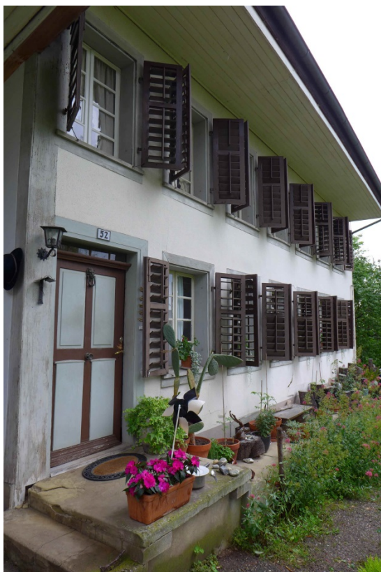
Fassade mit tennseitigem Hauseingang (2016)
