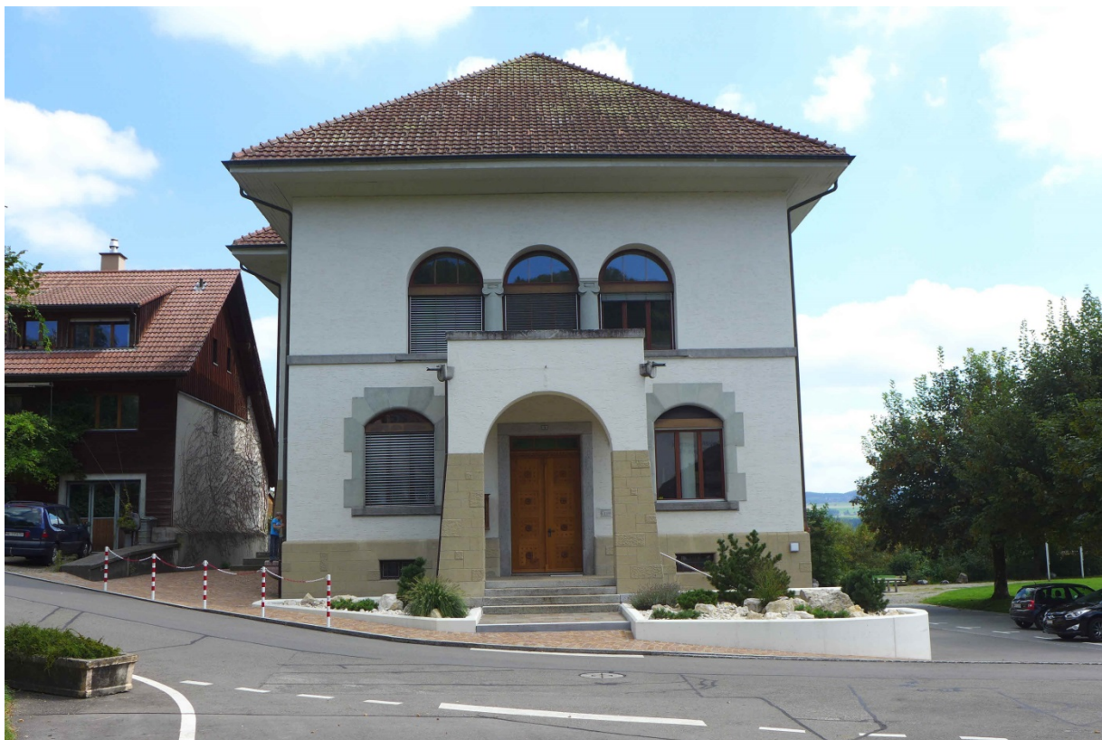
Westliche Eingangsfront mit Portalvorbau (2016)
