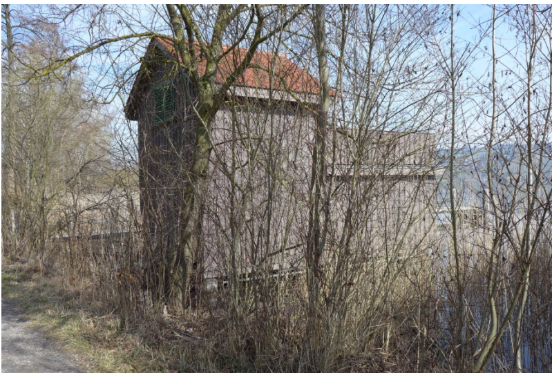
Bootshaus Vers.-Nr. 41, Ansicht von Süden (2017)
