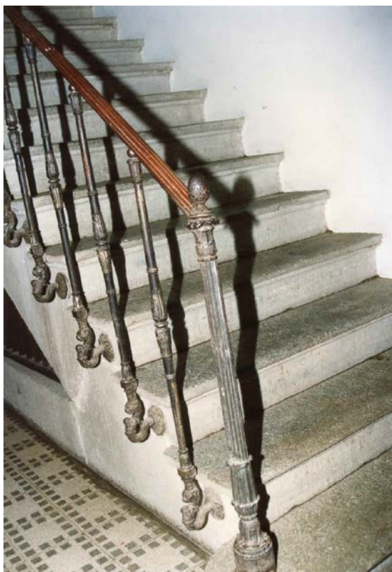
Interner Treppenaufgang mit filigranem Gusseisengeländer (Kurzinventar 1992)
