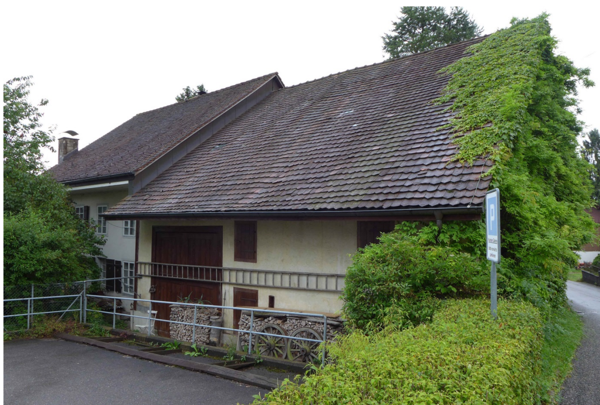
Ansicht rückwärtige Nordfassade (2016)
