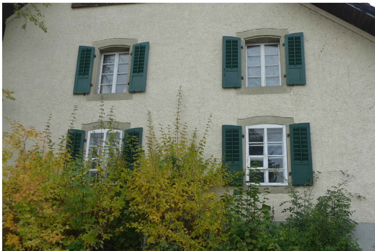
Östliche Stirnfassade mit stichbogigen Fensteröffnungen (2016)
