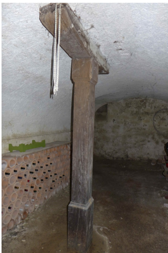
Tonnengewölbter Keller mit Mittelstütze (2016)
