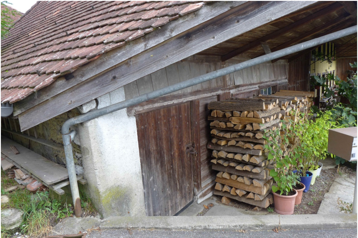
Scheunenteil mit mächtiger Bruchsteinmauer und älteren Holzteilen (2016)
