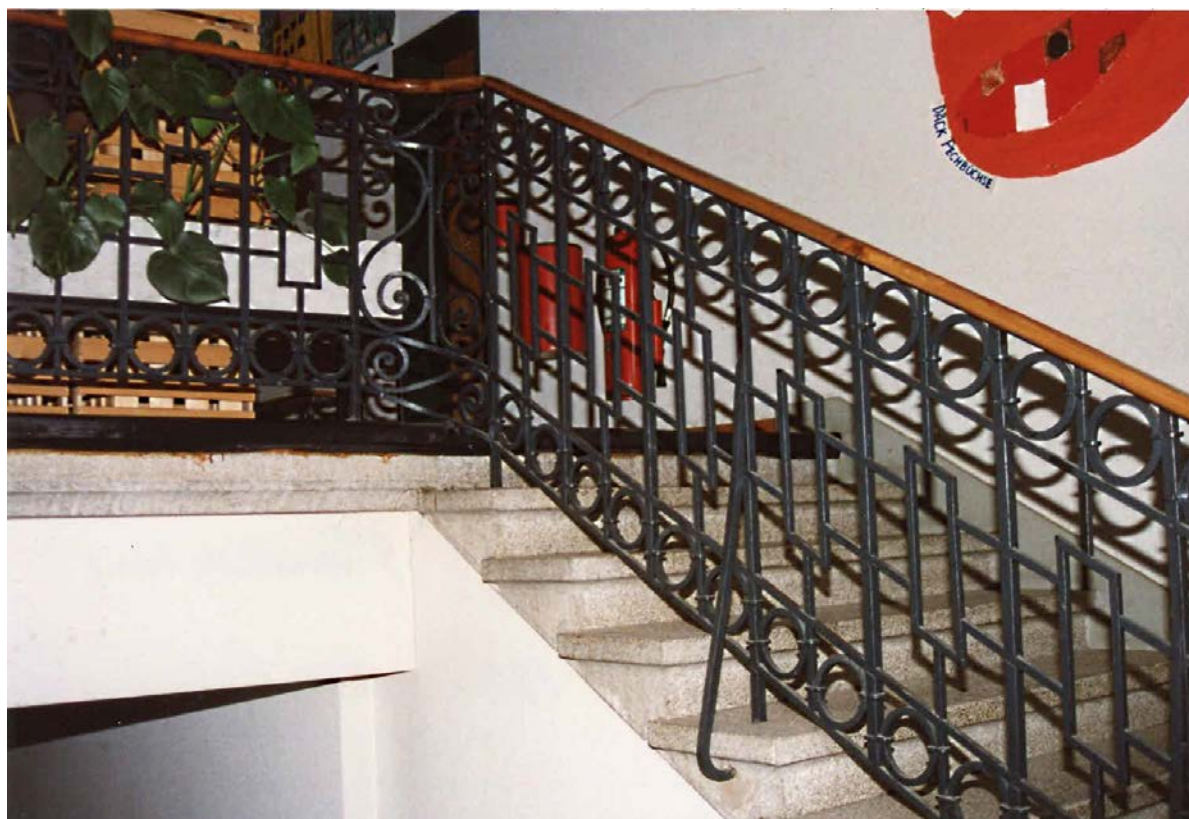
Treppenhaus mit bauzeitlichem Eisengeländer (Kurzinventar 1992)
