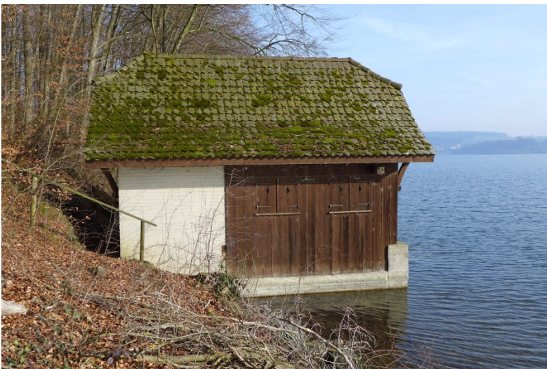
Bootshaus Vers.-Nr. 202, Ansicht von Süden (2017)
