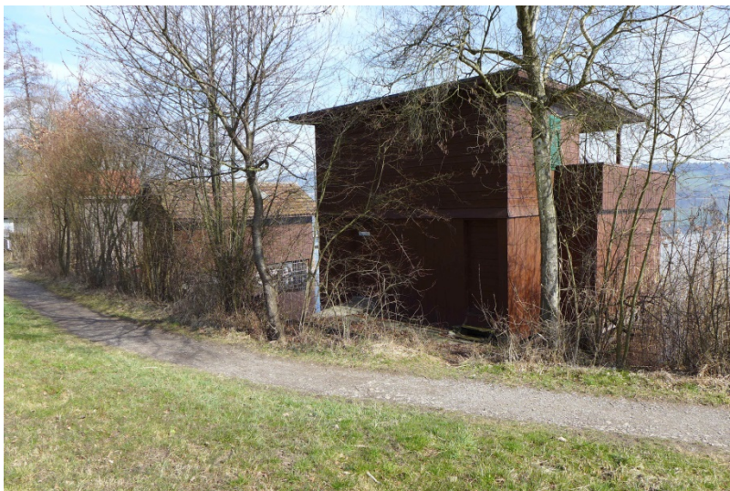
Bootshaus Vers.-Nr. 236, Ansicht von Süden (2017)
