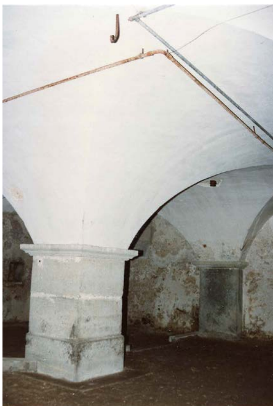
Keller mit Kreuzgratgewölbe und kräftigem Mittelpfeiler (Kurzinventar 1992)
