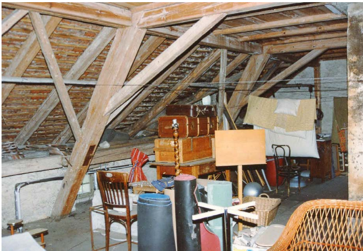
Dachkonstruktion mit liegendem Stuhl (Kurzinventar 1992)
