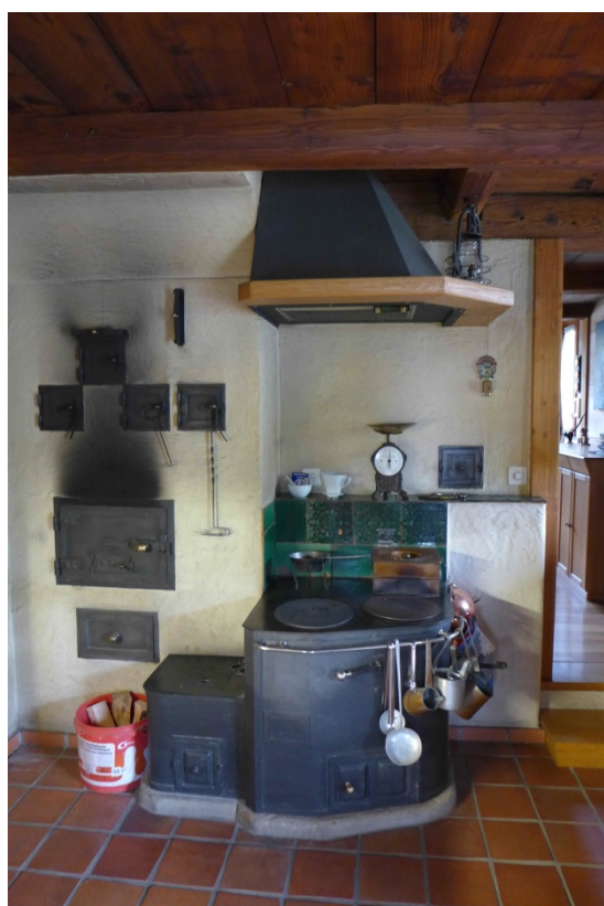
Eiserner Sparherd Küche westlicher Hausteil (2016)
