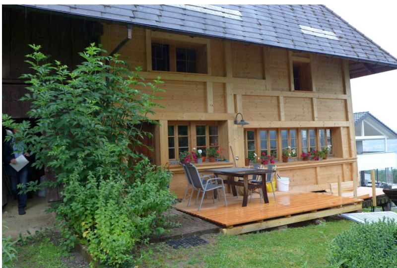
Südliche Stubenfront mit neuer Fassade (Aufnahme 2016)
