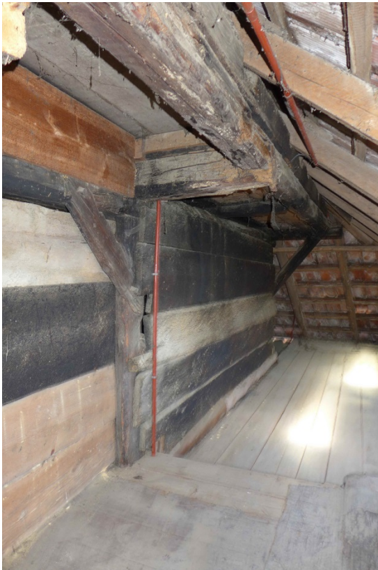
Bohlenwand im rückwärtigen Hausbereich, ehemalige Aussenwand (2016)
