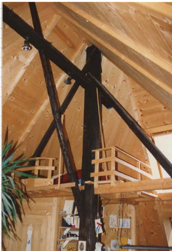
Hochstudkonstruktion im ausgebauten Dachgeschoss (Kurzinventar 1992)
