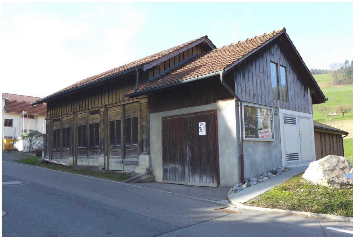
Jüngerer nördlicher Garagenanbau (2016)
