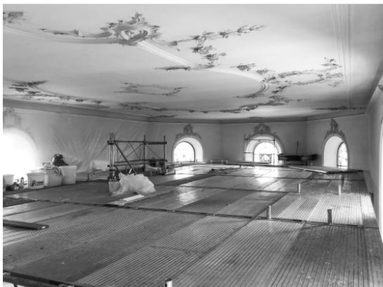
Erst nach der Erstellung eines Baugerüsts und Aufnahme der gesamten Decke wurde der desolate Zustand sichtbar. Es wurde festgestellt, dass der Kalkgehalt der Bausubstanz bereits bei der Erstellung zu gering war. Auch der Einbau zur Befestigung an der Dachkonstruktion war schon zu dieser Zeit fehlerhaft, dazu kommen kleinere natürliche Senkungen am Mauerwerk. Ein Eindringen von Dachwasser konnte definitiv ausgeschlossen werden.
